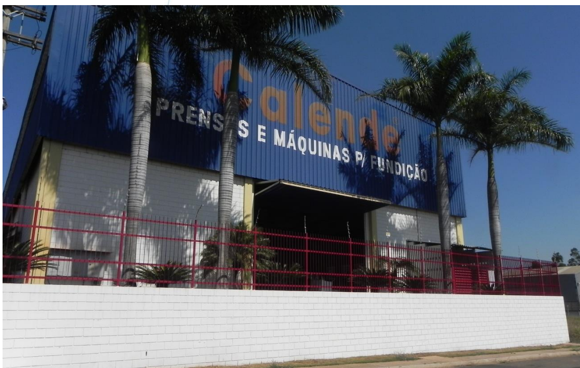
Foto 002: Parte externa lateral
