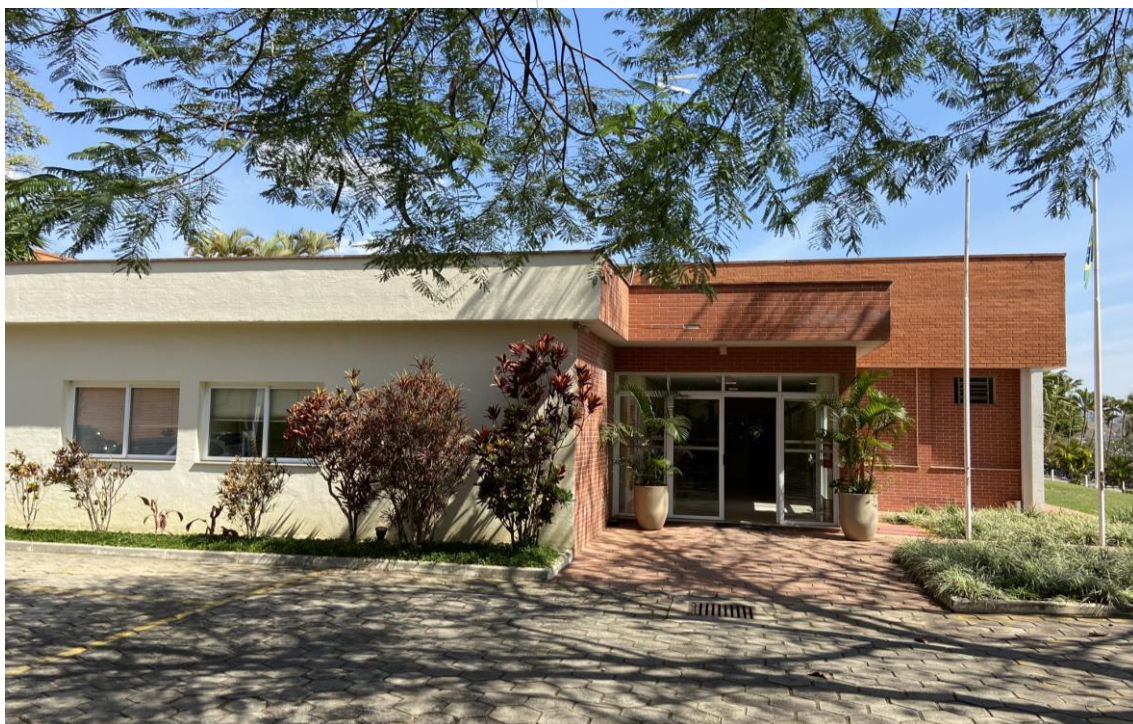
Foto 005: Entrada para recepção, setor administrativo e operacional
