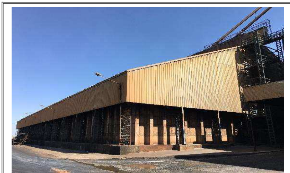
FOTO N. 17 GALPÃO DE AÇÚCAR
