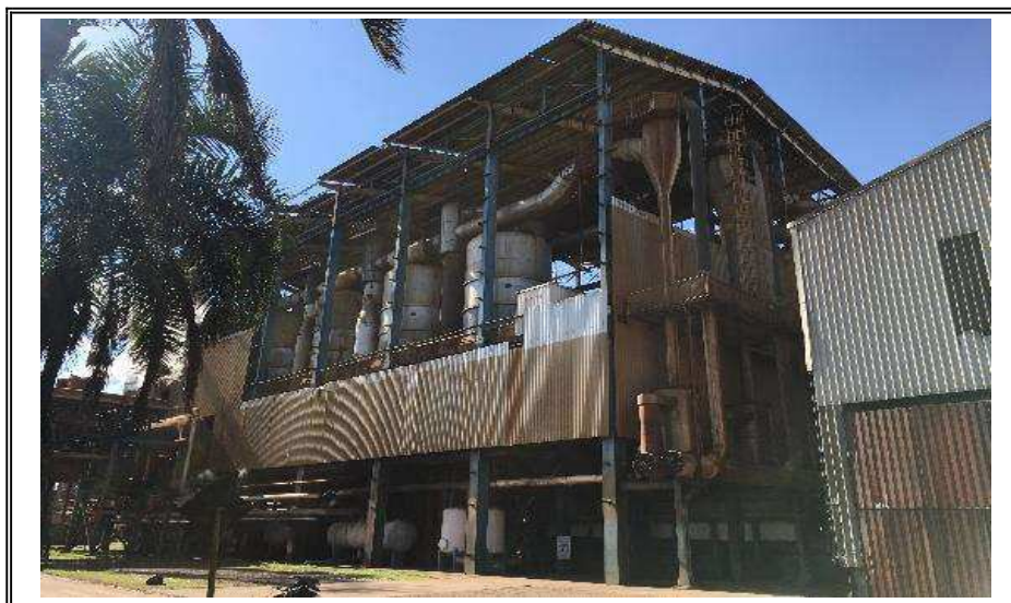
FOTO N. 15 FÁBRICA DE AÇÚCAR
