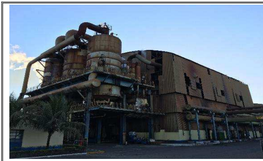
FOTO N. 6 FÁBRICA DE AÇÚCAR
