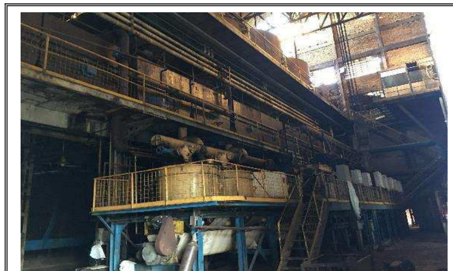
FOTO N. 8 FÁBRICA DE AÇÚCAR
