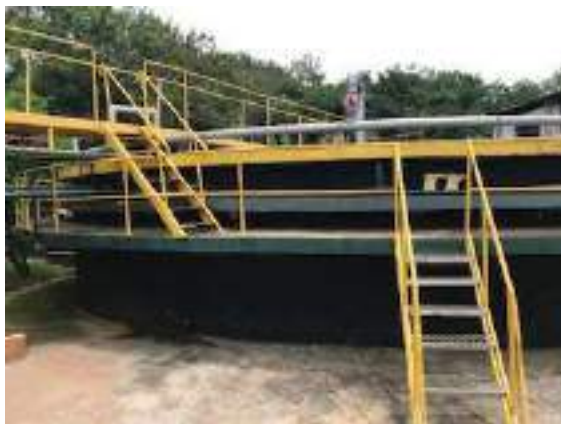
REATOR ANAERÓBIO DE FLUXO ASCENDENTE
