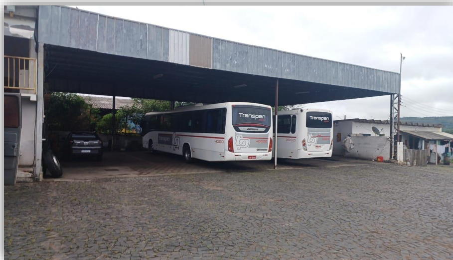
Foto 038: Pátio para armazenamento de frota (continuação)
