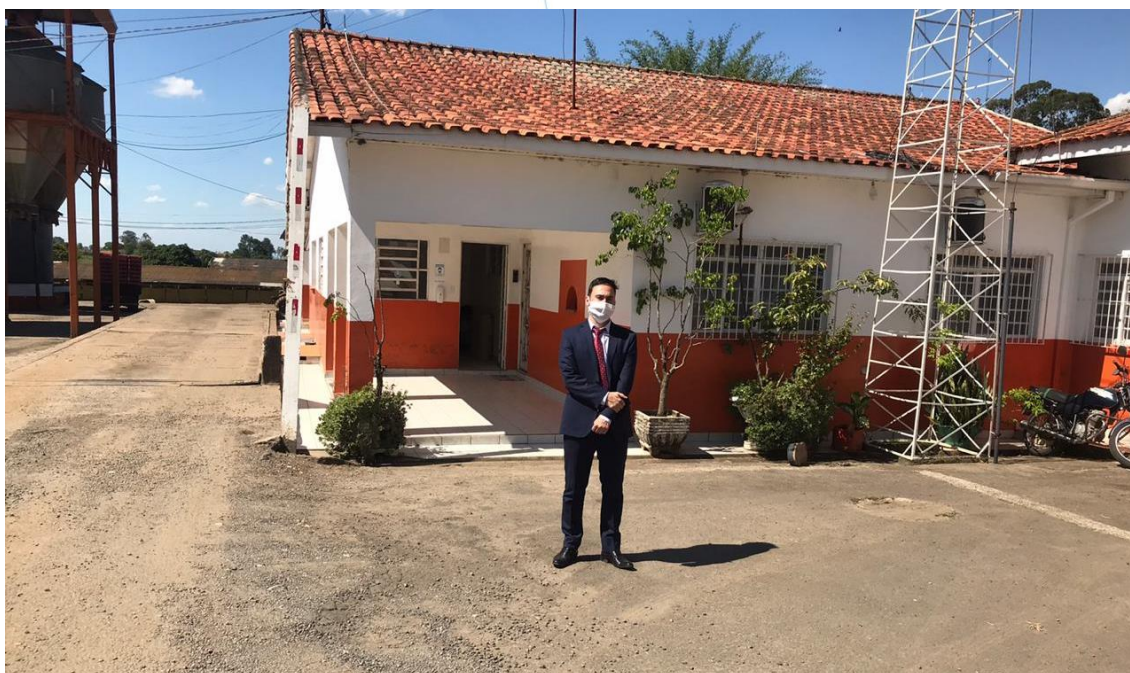
Foto 003: Parte externa do setor administrativo da empresa.
