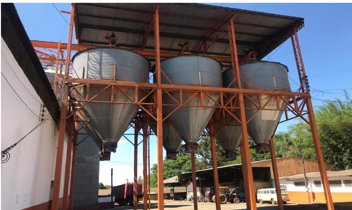
Foto 010: Maquinário para carregamento e distribuição.
