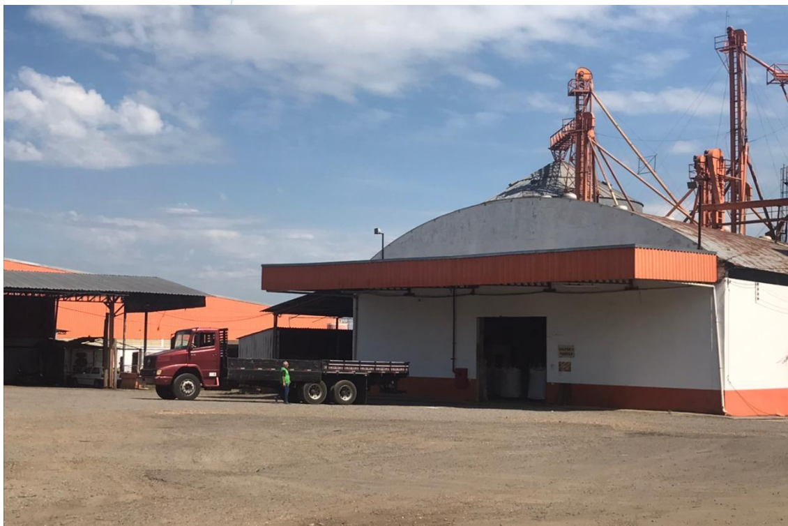
Foto 014: Galpão de operação.
