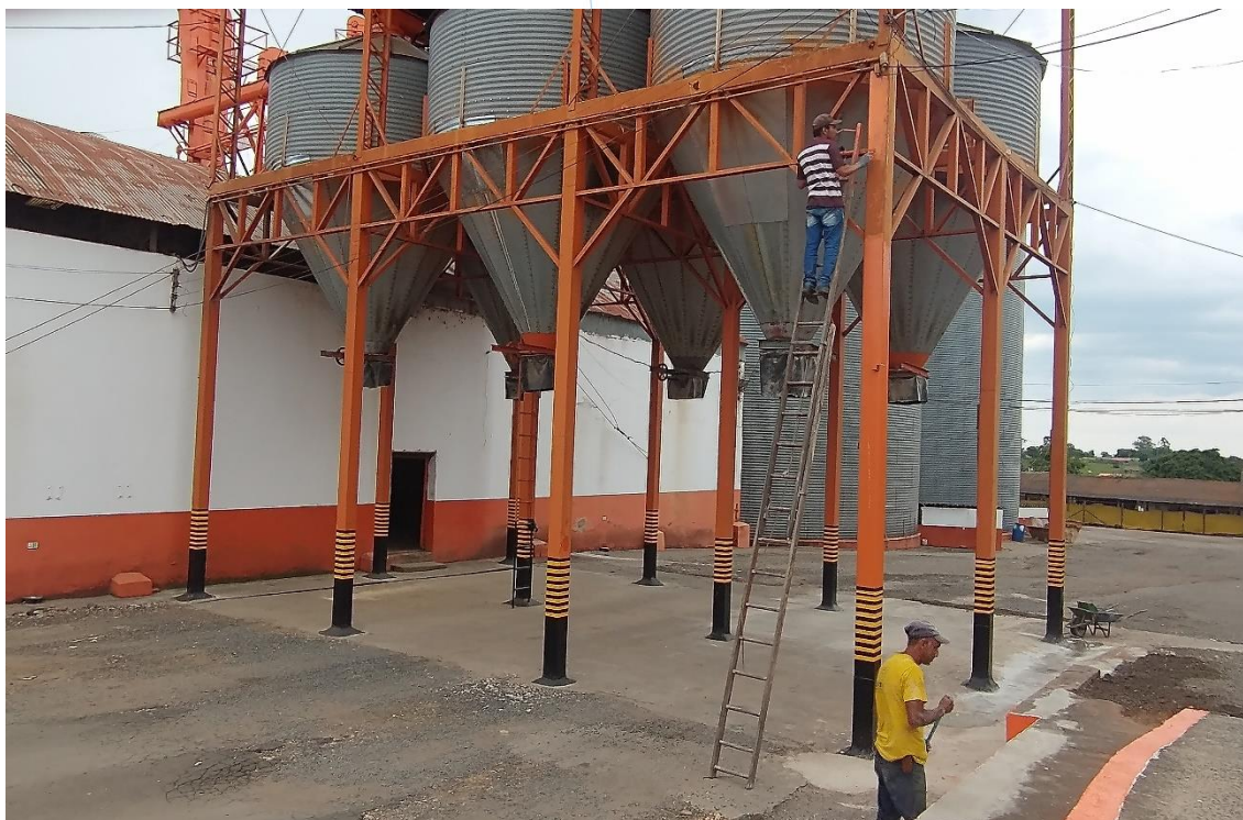
Foto 013: Colaboradores trabalhando na manutenção da estrutura dos silos de armazenagem
