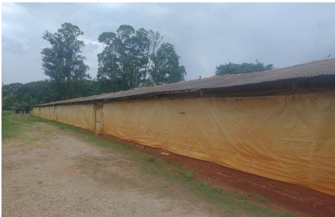
Foto 020: Vista externa da granja (continuação)
