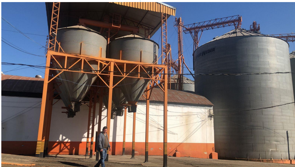
Foto 009: Tanques de abastecimento
