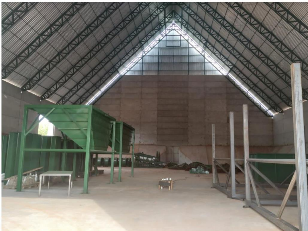
Vista interna do Armazém, fase em instalação de equipamentos
