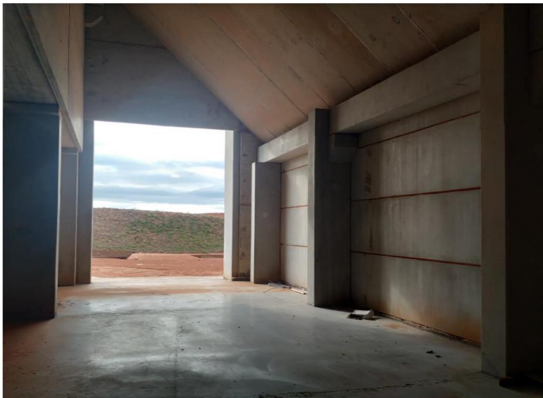
Vista interna piso acabado
