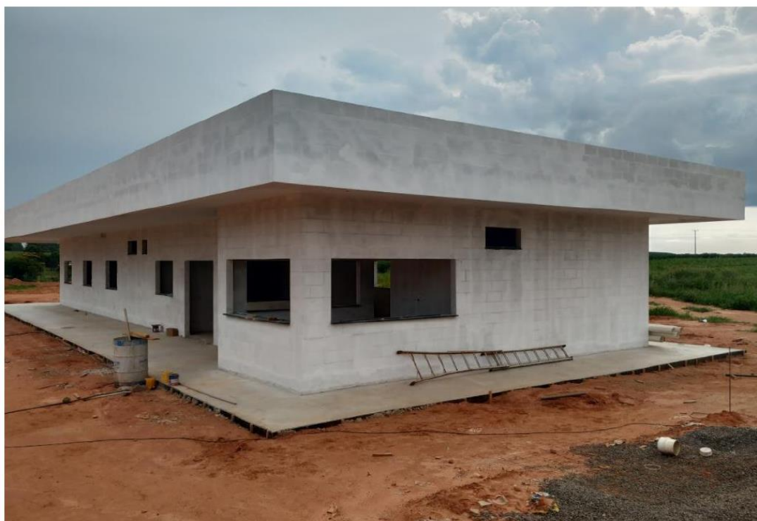
Escritório em construção
