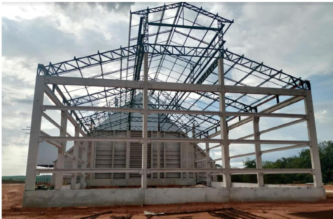
Armazém pronto aos fundos e estrutura concluída à frente em pré-moldado de concreto e cobertura em estrutura metálica
