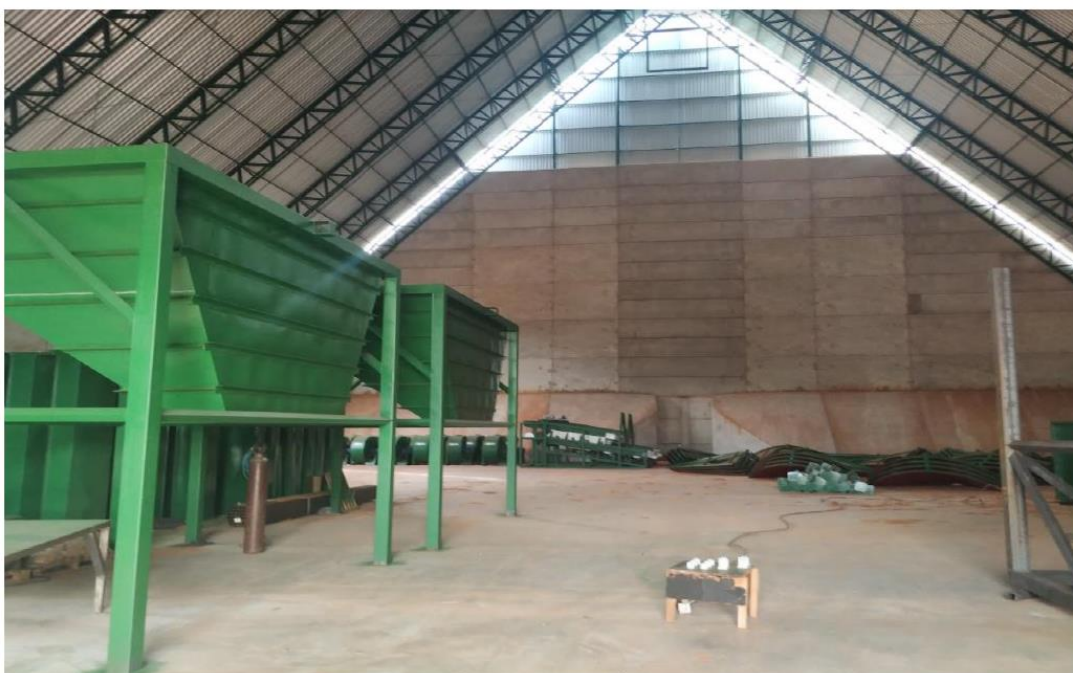
Fase de instalação de equipamentos
