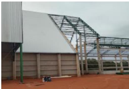
Foto 25 - Área em construção
