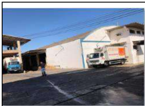
VISTA DO ABATEDOURO/REFRIGERAÇÃO
