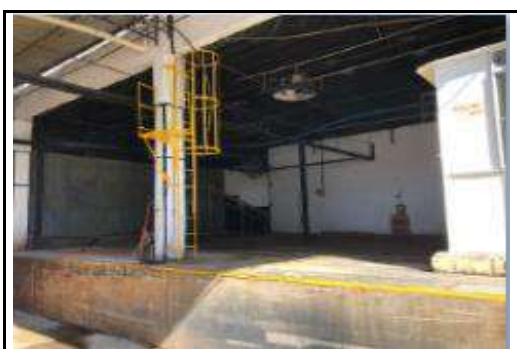
VISTA DO PRÉDIO DO ABATEDOURO
