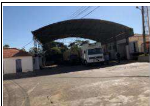
GALPÃO / ALMOXARIFADO PRINCIPAL
