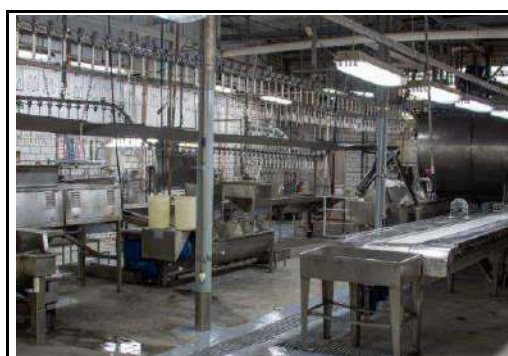
VISTA DO PRÉDIO DO ABATEDOURO
