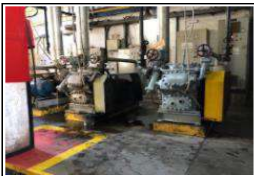
CASA DE MAQUINAS
