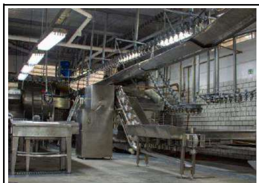
VISTA DO PRÉDIO DO ABATEDOURO
