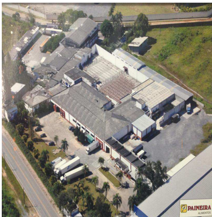
Vista aérea das instalações da Paineira
