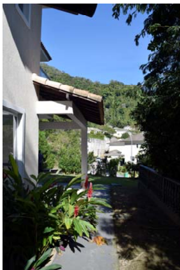
Fotos 07 e 08: Fachada frontal
