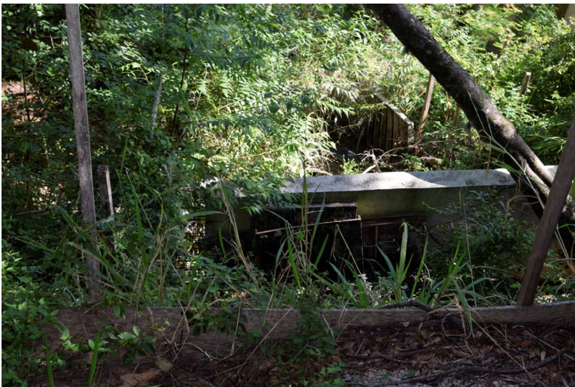
Foto 30: Contenção realizada pela construtora
