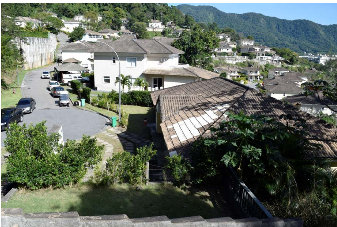
Foto 28: Vista da residência – 2º Pavimento
