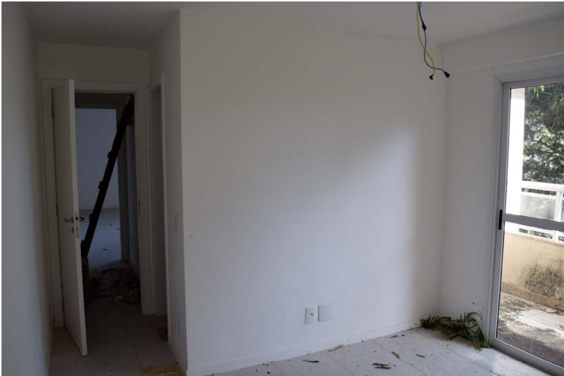
Foto 24: Suite – 2º pavimento
