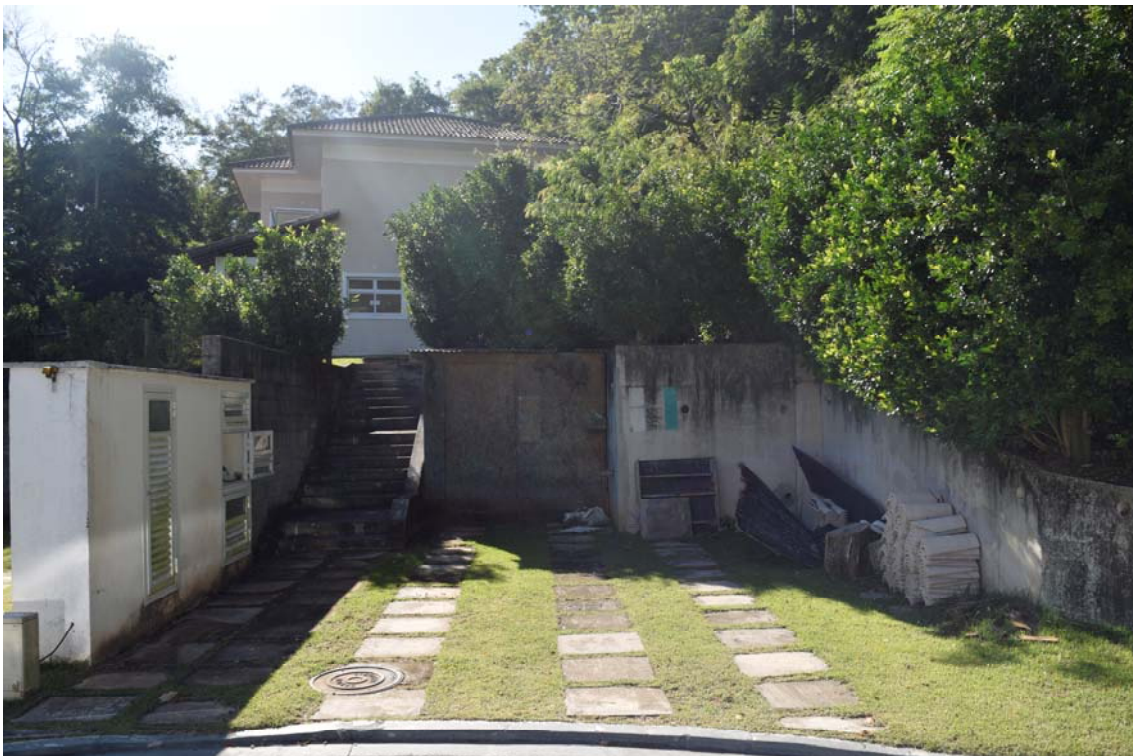
Foto 02: Garagem e acesso à residência
