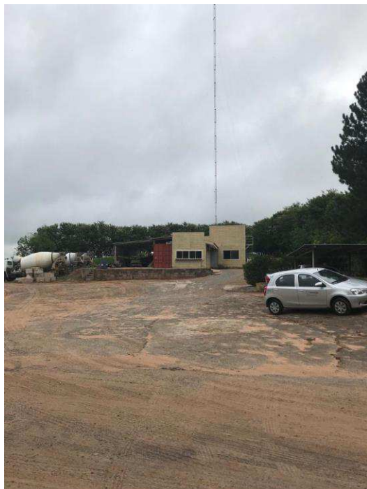
Foto 013: Vista do prédio administrativo a partir da entrada da empresa.
