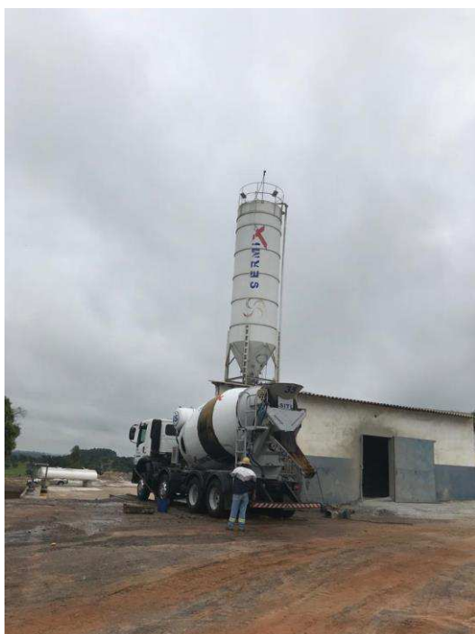
Foto 006: Betoneira sendo carregada para expedição.
