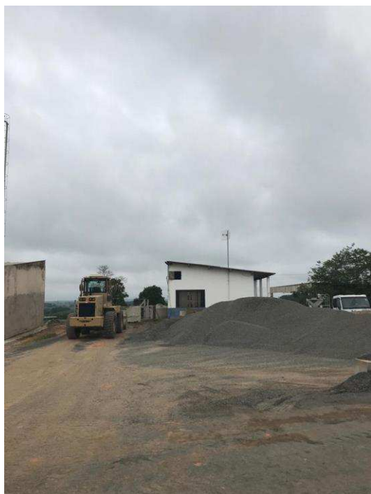
Foto 010: Setor de matéria prima para produção do concreto.
