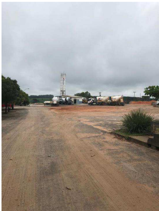
Foto 005: Pátio de carregamento e expedição (continuação).
