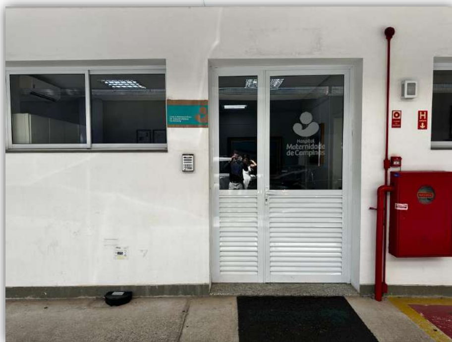
Foto 003: Entrada para as dependências do setor administrativo
