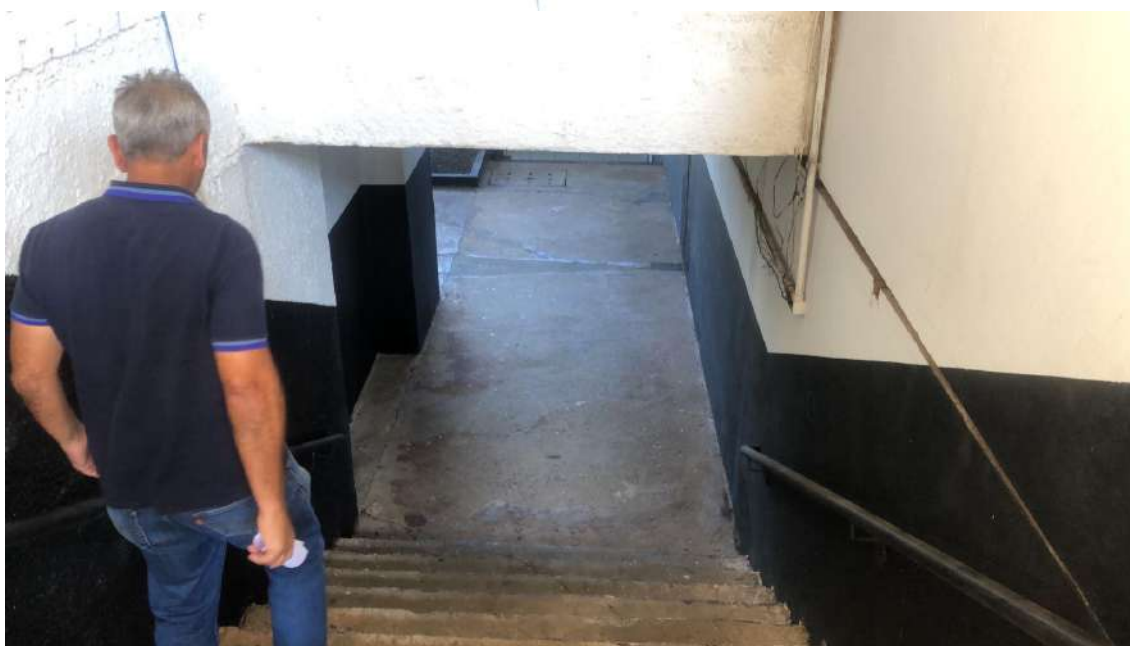
Foto 012: Escadas para alojamento
