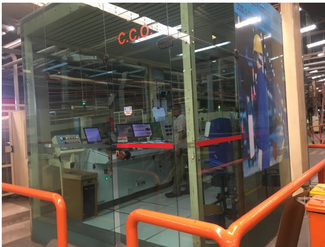
Foto 023: Detalhe da sala de controle de operação
