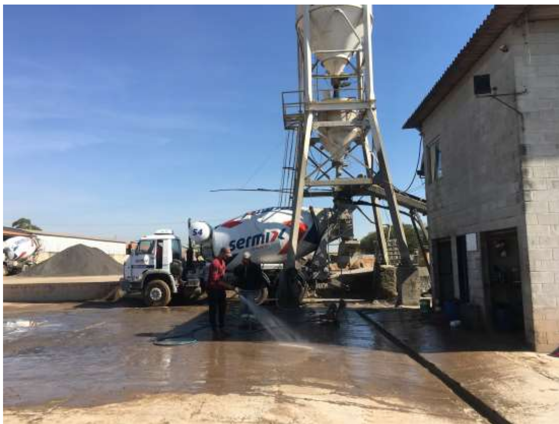
Foto 078: Betoneira 54 na torre de cimento para ser carregada
