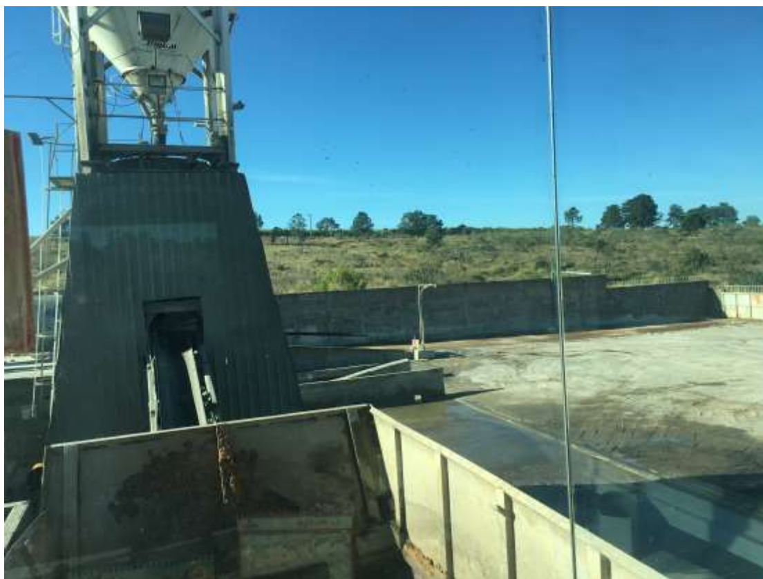
Foto 002: Vista do pátio com a torre de cimento
