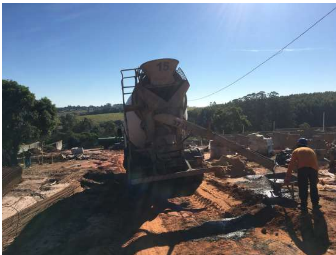
Foto 013: Betoneira 15 descarregando em obra de Pardinho/SP.
