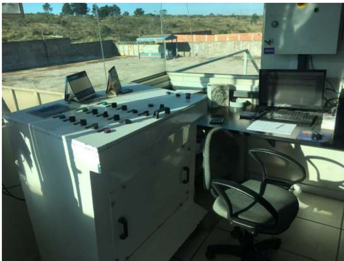
Foto 007: Sala de controle da torre de cimento e balança
