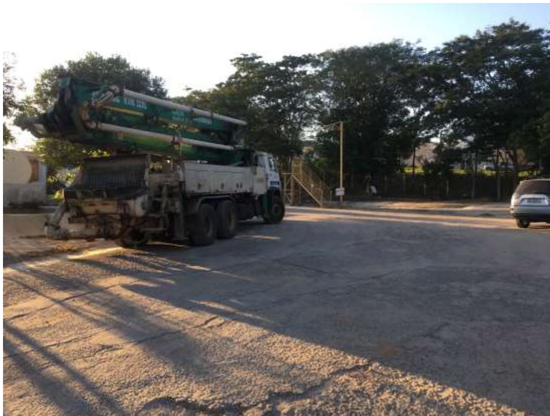
Foto 062: Caminhão bomba de concreto
