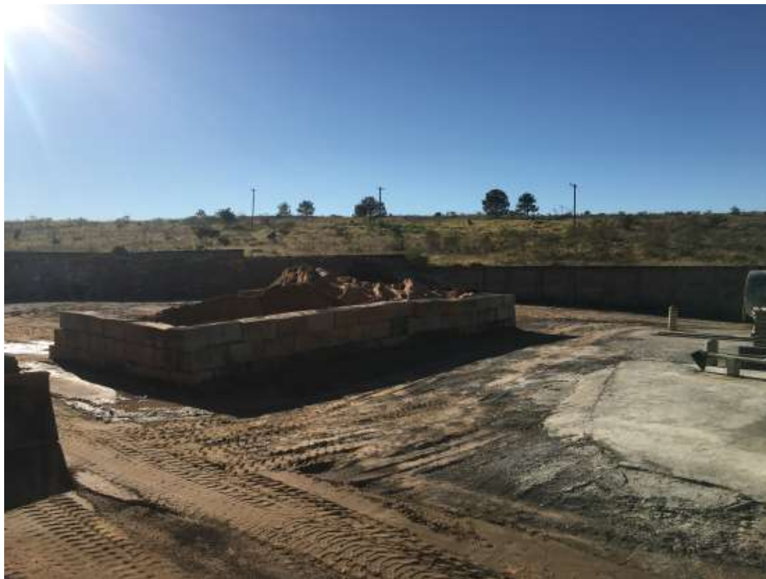
Foto 004: Vista do pátio
