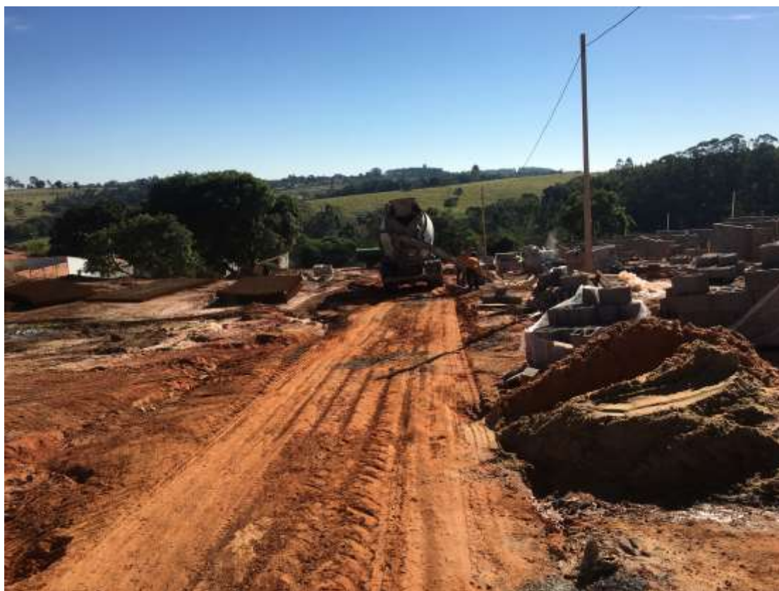
Foto 012: Betoneira 15 (DAH6157) descarregando em obra de Pardinho/SP.
