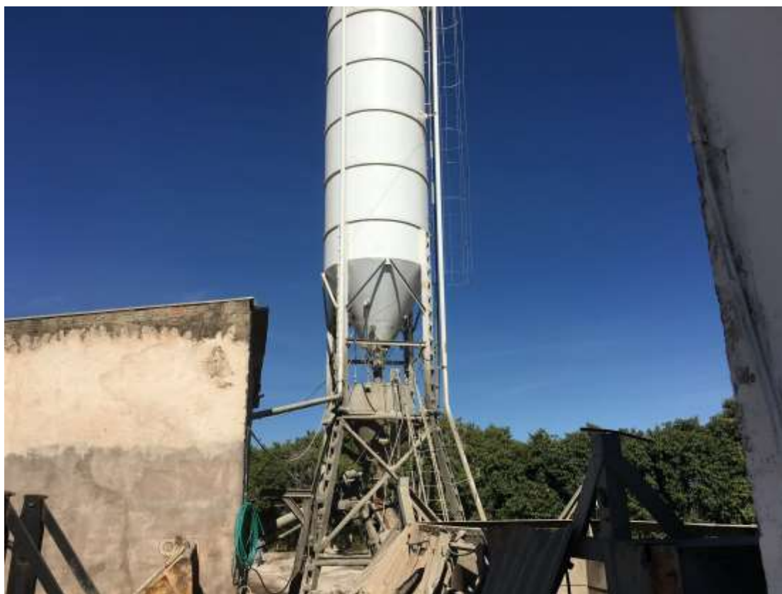
Foto 033: Detalhe da torre de cimento
