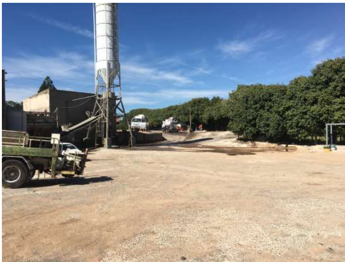
Foto 029: Torre de cimento com caminhões ao lado.
