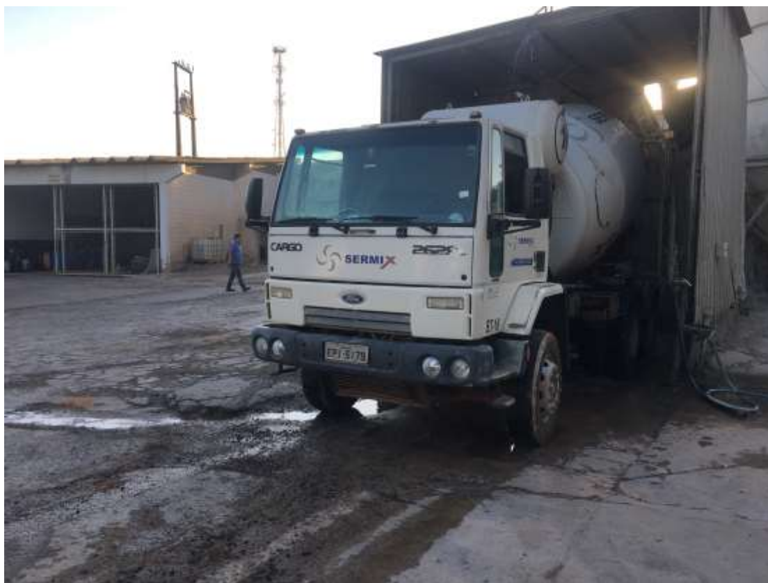
Foto 068: Detalhe da betoneira na doca de carga
