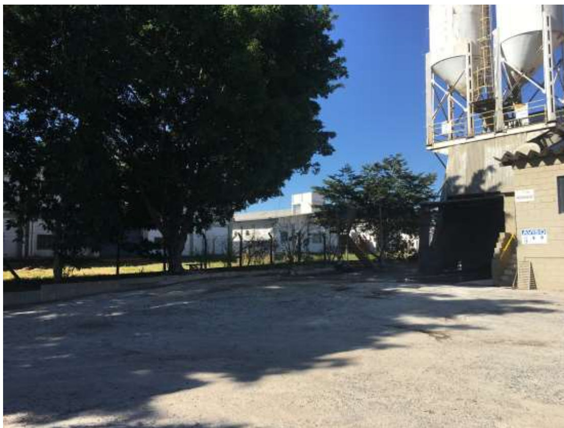
Foto 053: Base das torres de cimento e doca de carga
