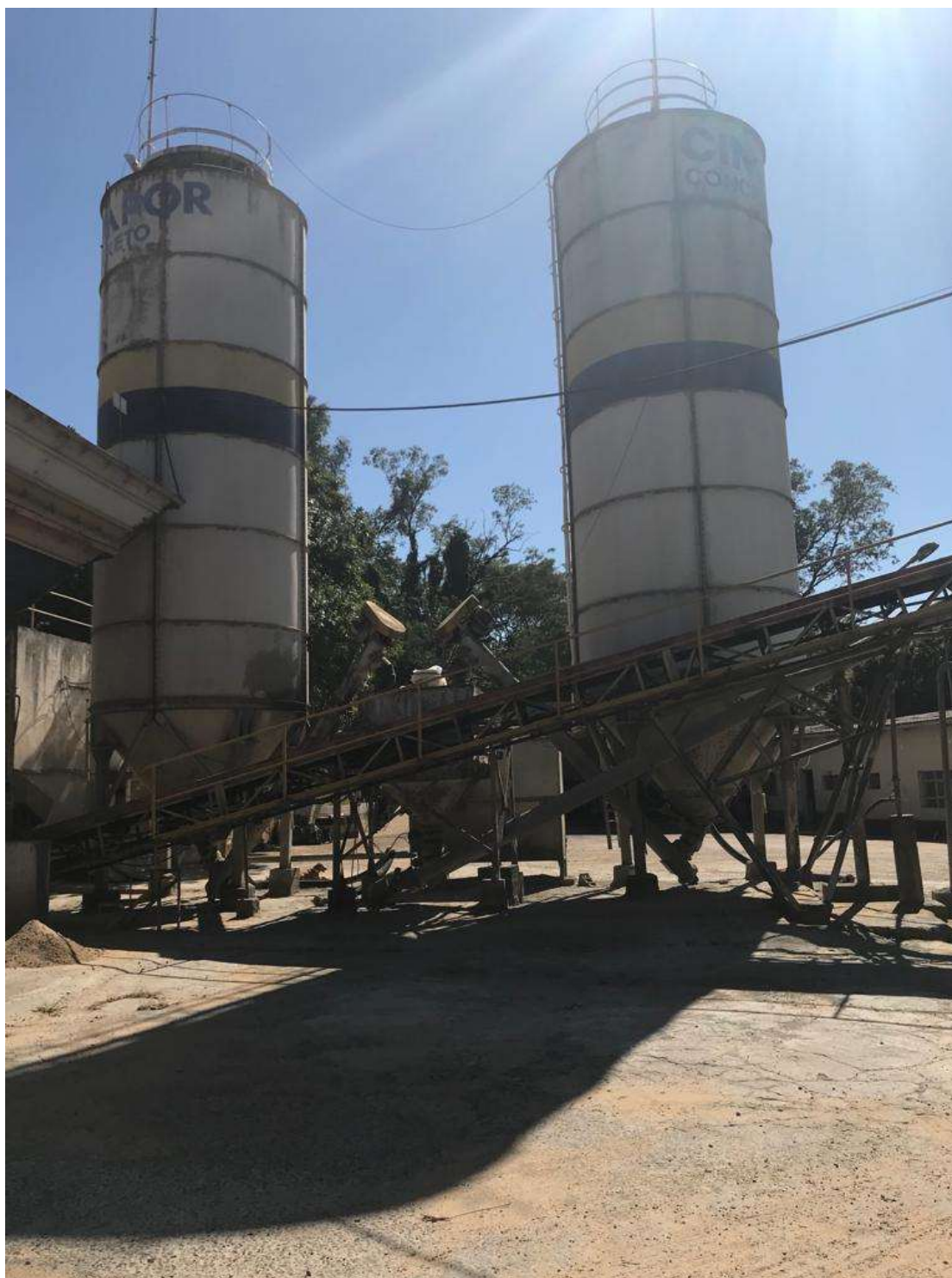
Foto 100: Torres de cimento e esteira de carregamento
