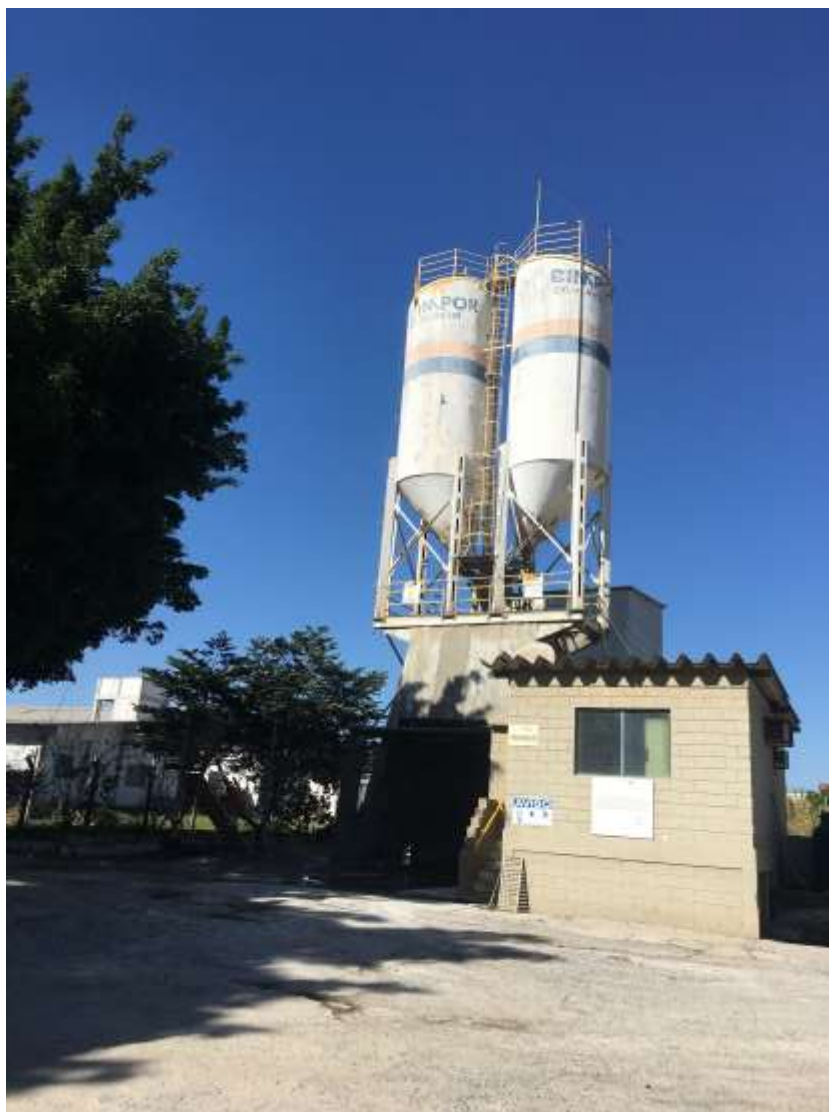
Foto 052: Torres de cimento
