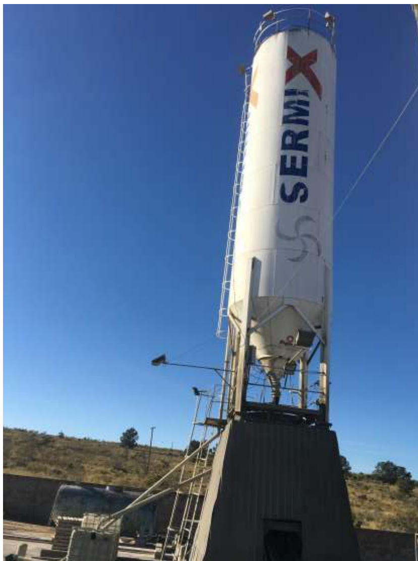
Foto 003: Torre de cimento
