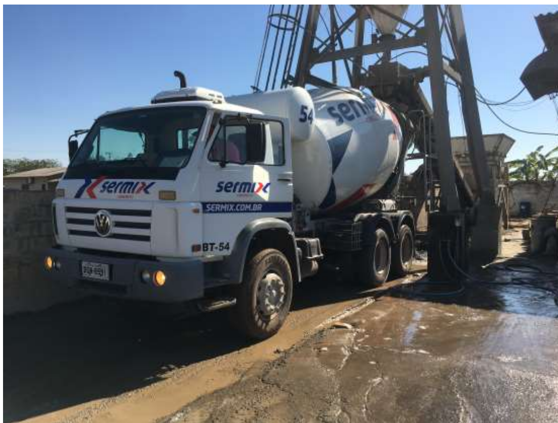
Foto 079: Detalhe da betoneira no processo de carga
