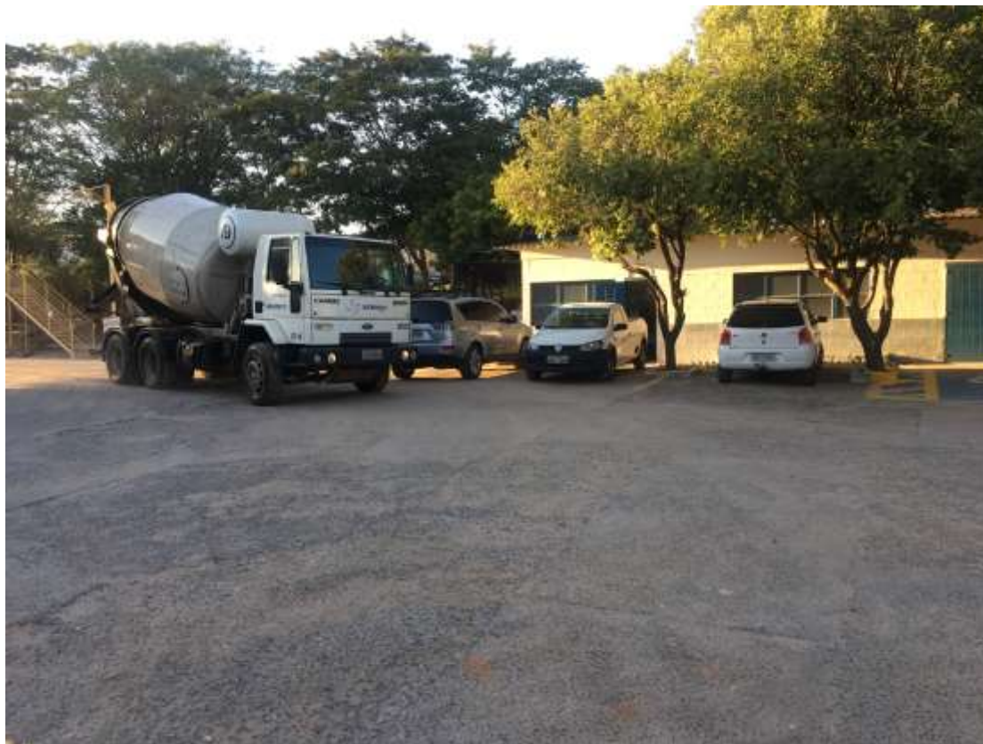
Foto 064: Betoneira recém-carregada, pronta para sair.
