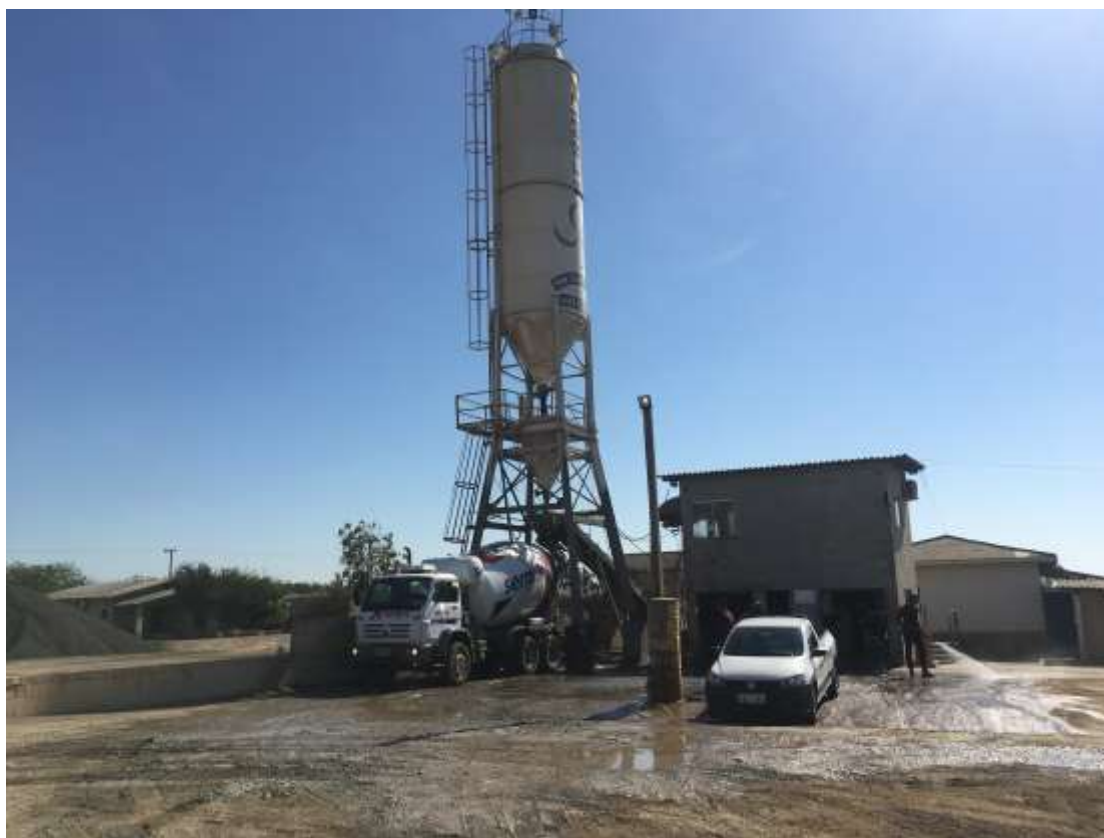
Foto 082: Vista da torre de cimento
