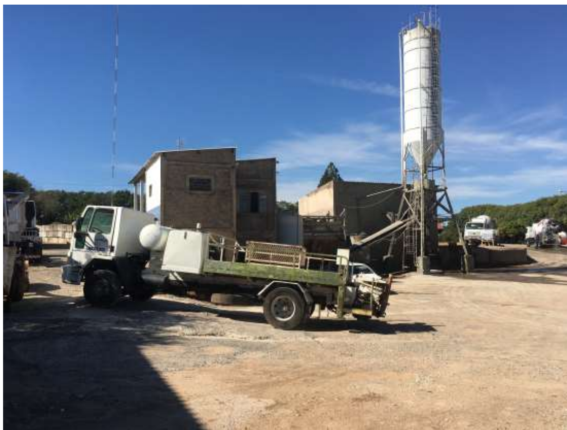
Foto 030: Torre de cimento e caminhão para bombear concreto.
