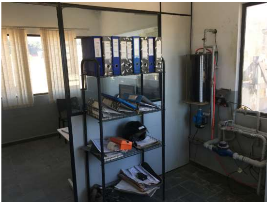
Foto 032: Sala de controle da torre de cimento
