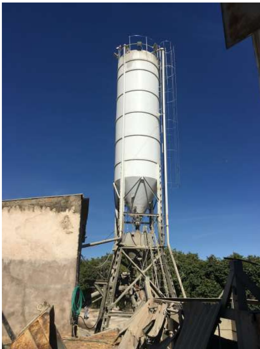
Foto 034: Torre de cimento
