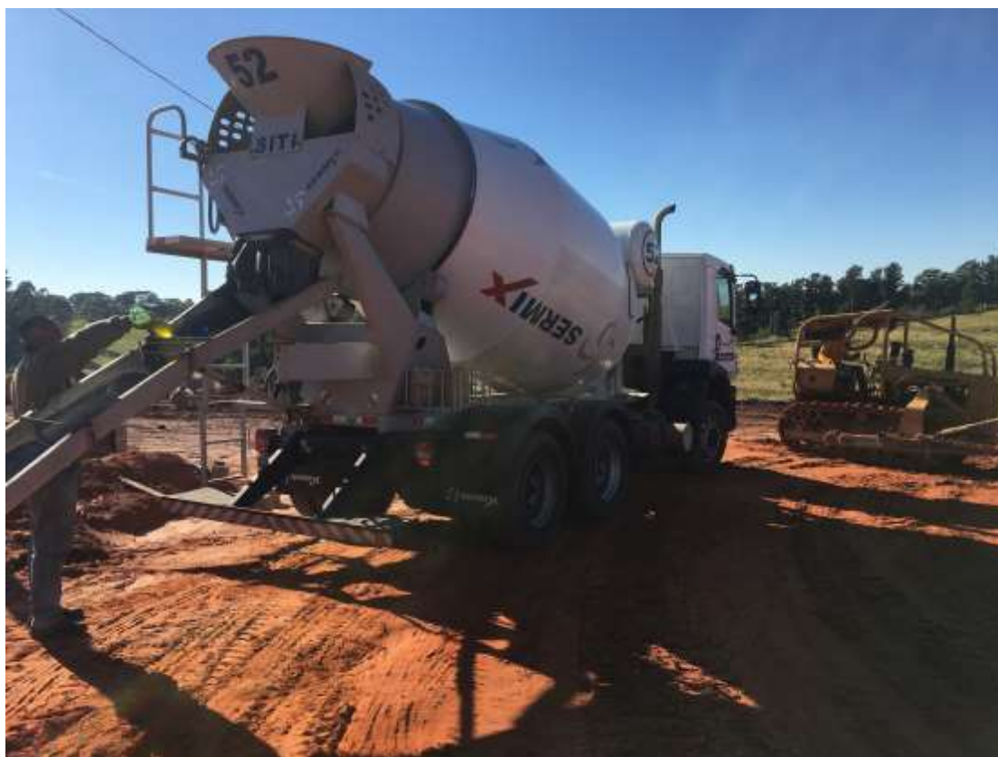
Foto 009: Betoneira descarregando em obra de Pardinho/SP
