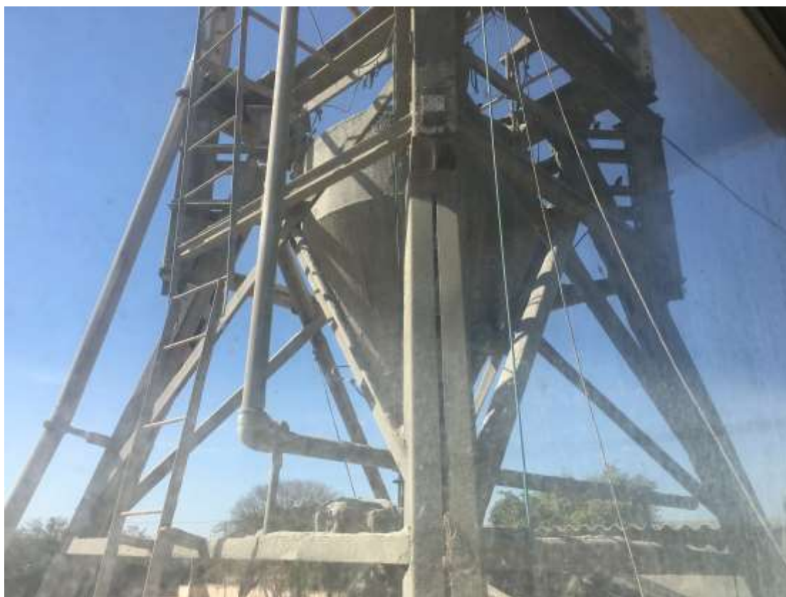
Foto 092: Detalhe da base da torre de cimento
