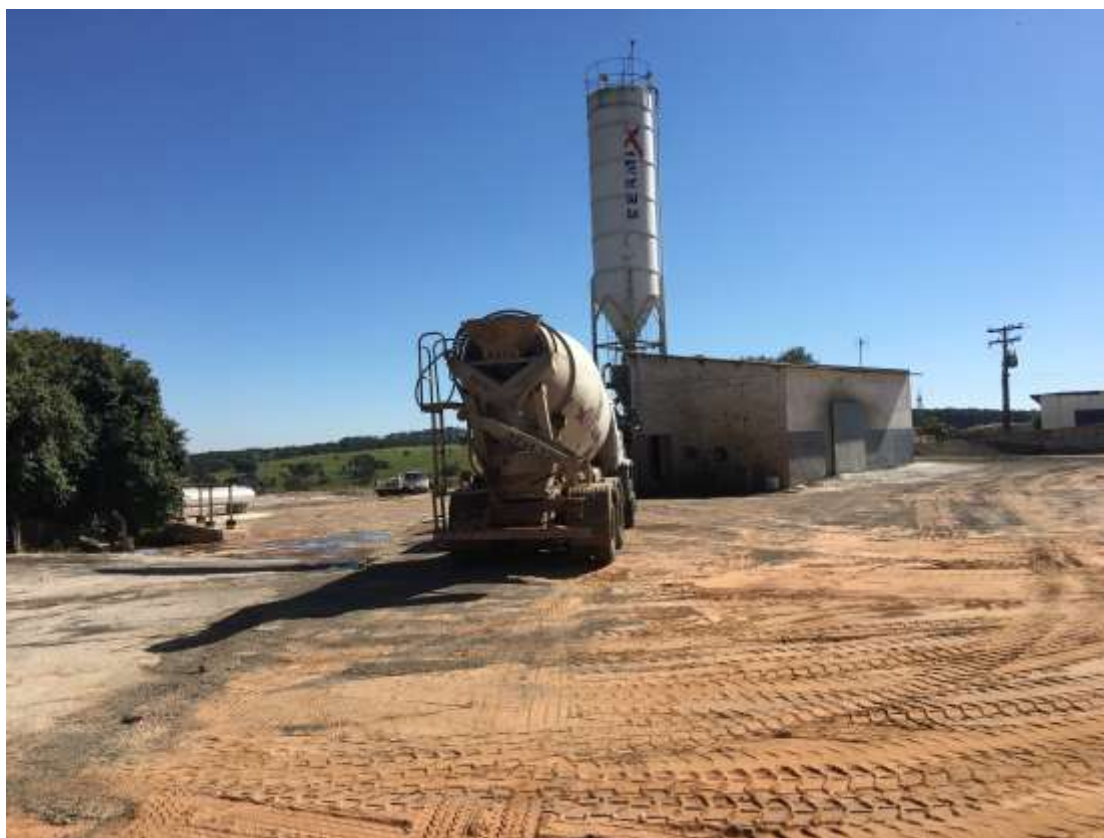
Foto 018: Betoneira em direção a torre de cimento. Notar o pátio limpo.
