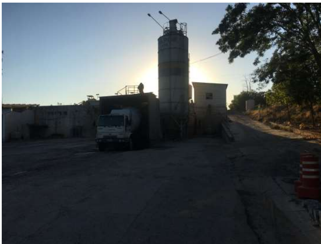
Foto 067: Betoneira em processo de carregamento
