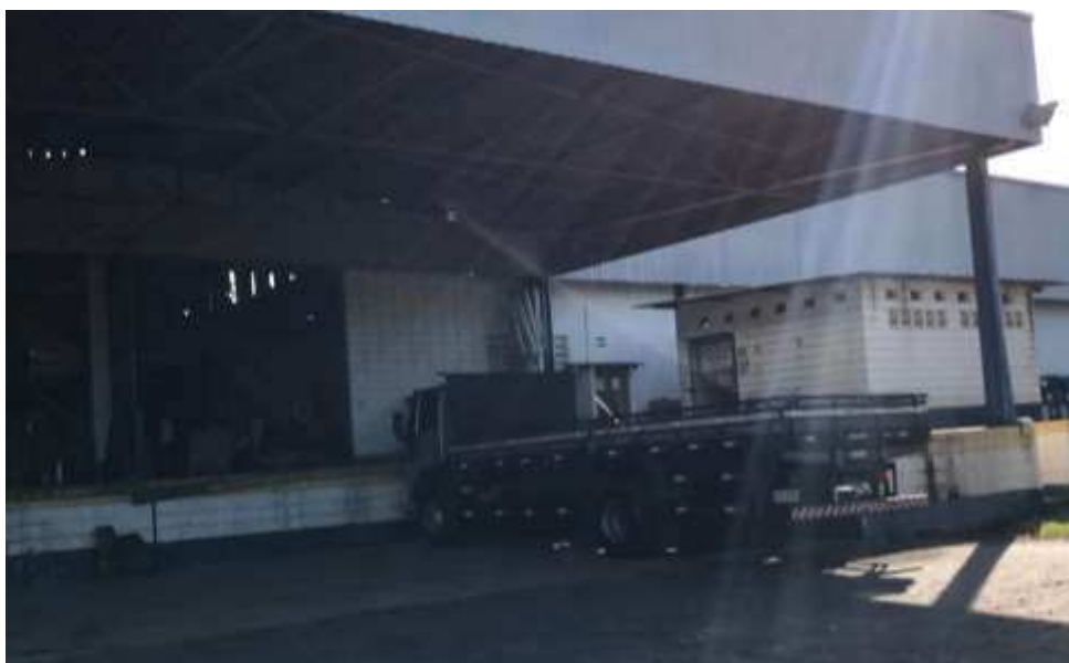
Foto 002: Píer de recepção e expedição de produtos com caminhão pronto.
