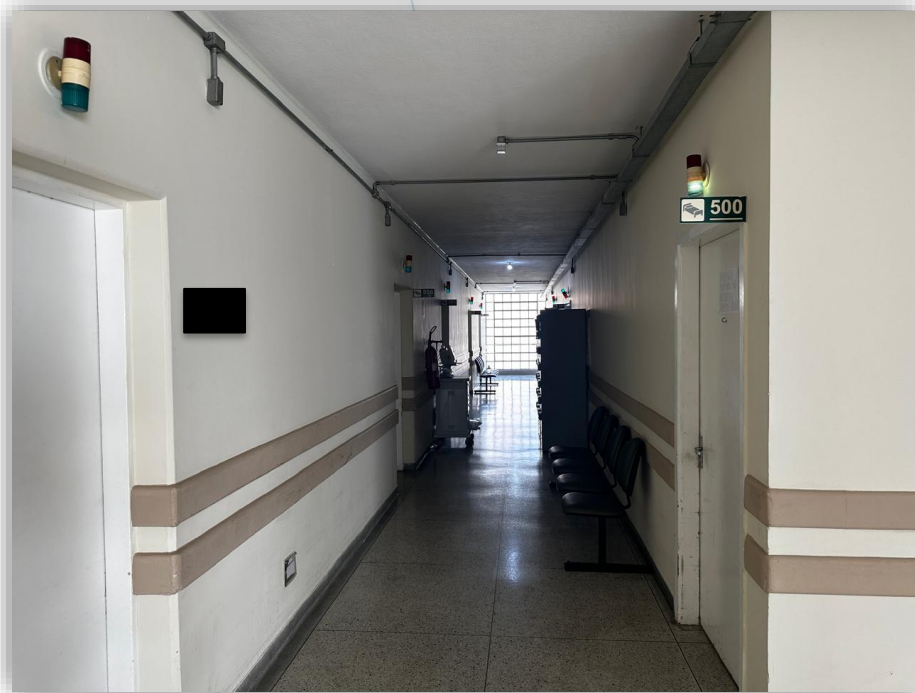
Foto 031: Corredor 5º Andar
