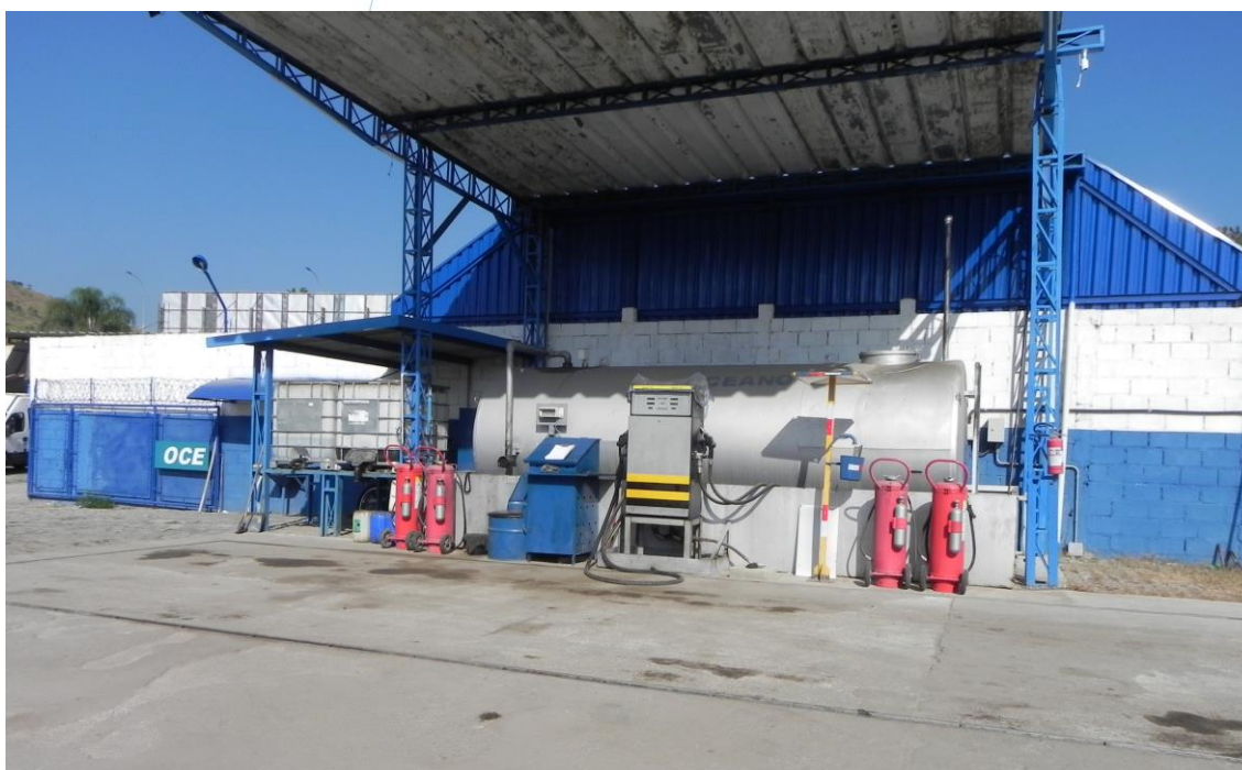
Foto 008: Posto de abastecimento dos veículos da frota
