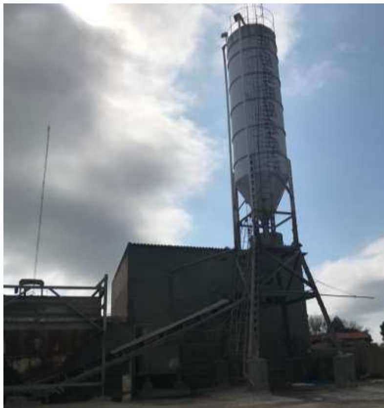
Foto 009: Torre de concreto
