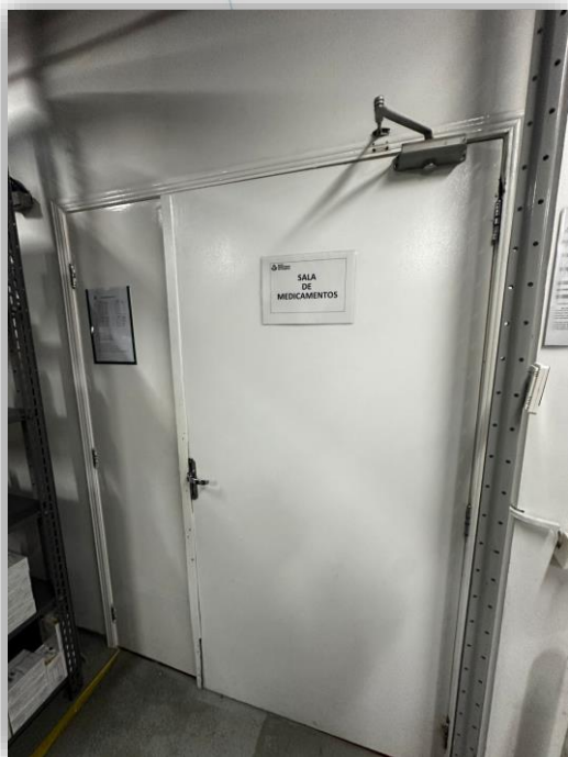
Foto 015: Sala de medicamentos
