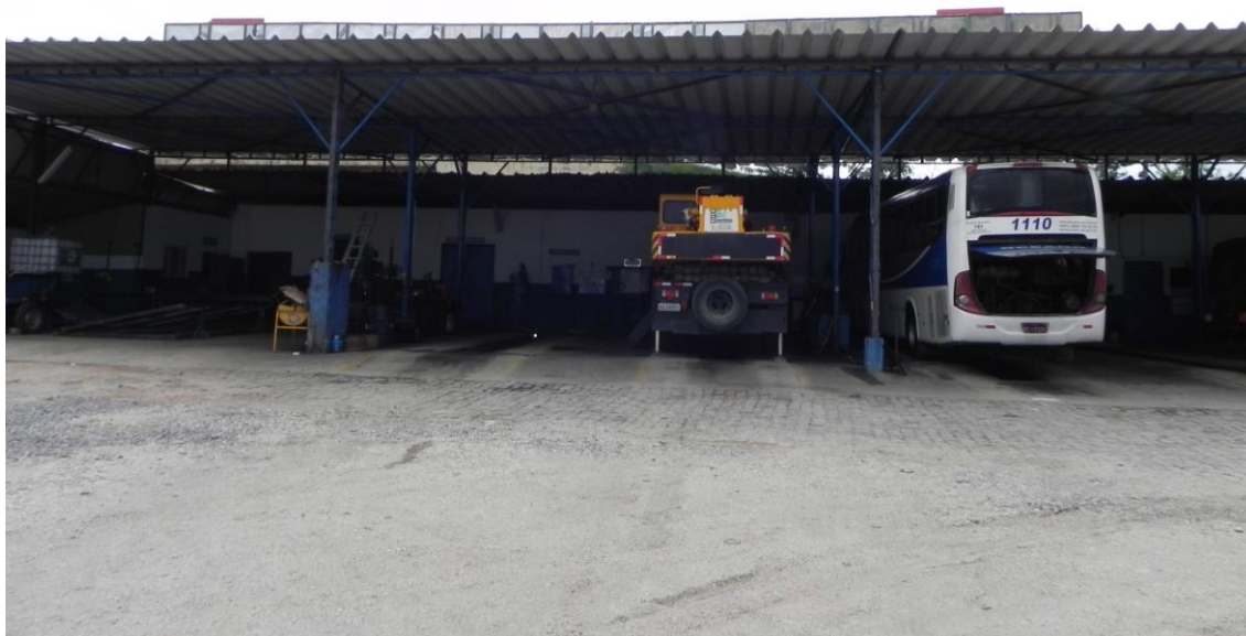
Foto 011: Vista da oficina mecânica
