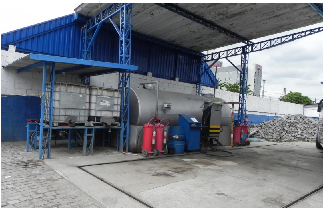
Foto 010: Posto de abastecimento
