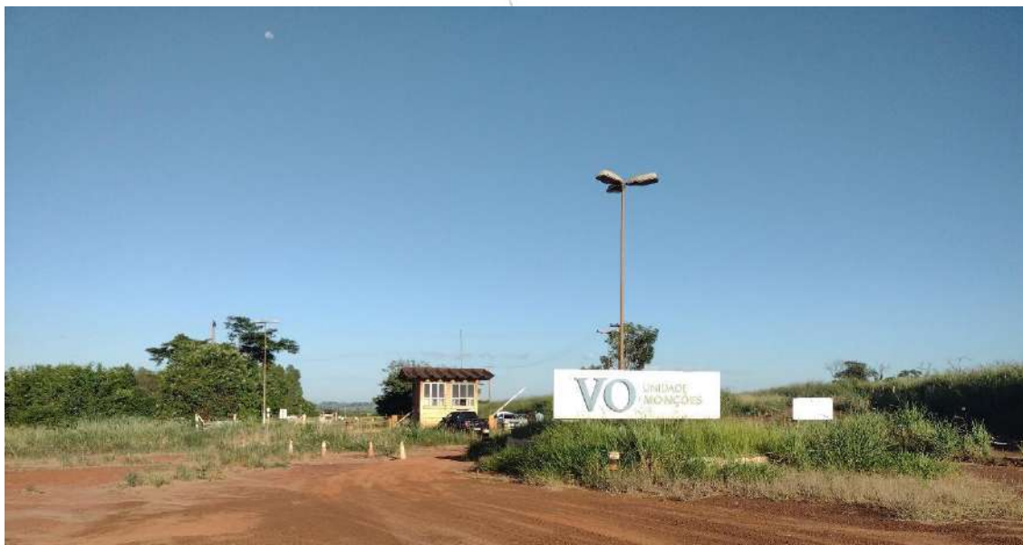
Foto 01 – Guarita Usina Monções
