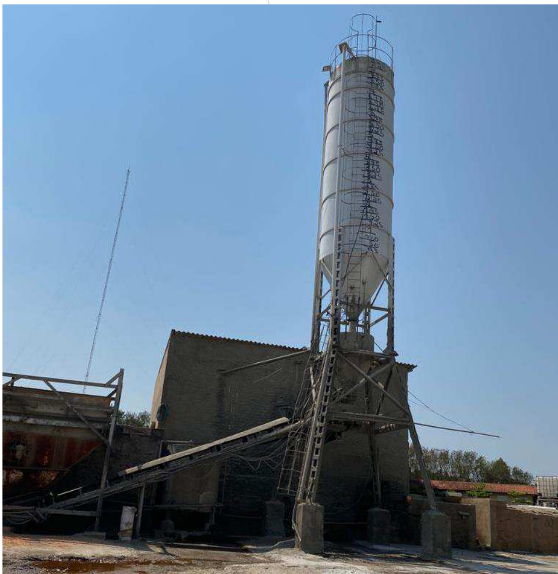
Foto 009: Torre de concreto
