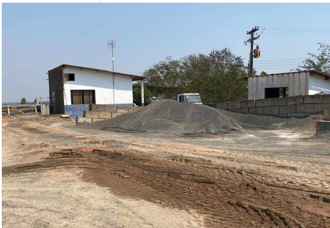
Foto 008: Armazenamento de pedras para fabricação de concreto
