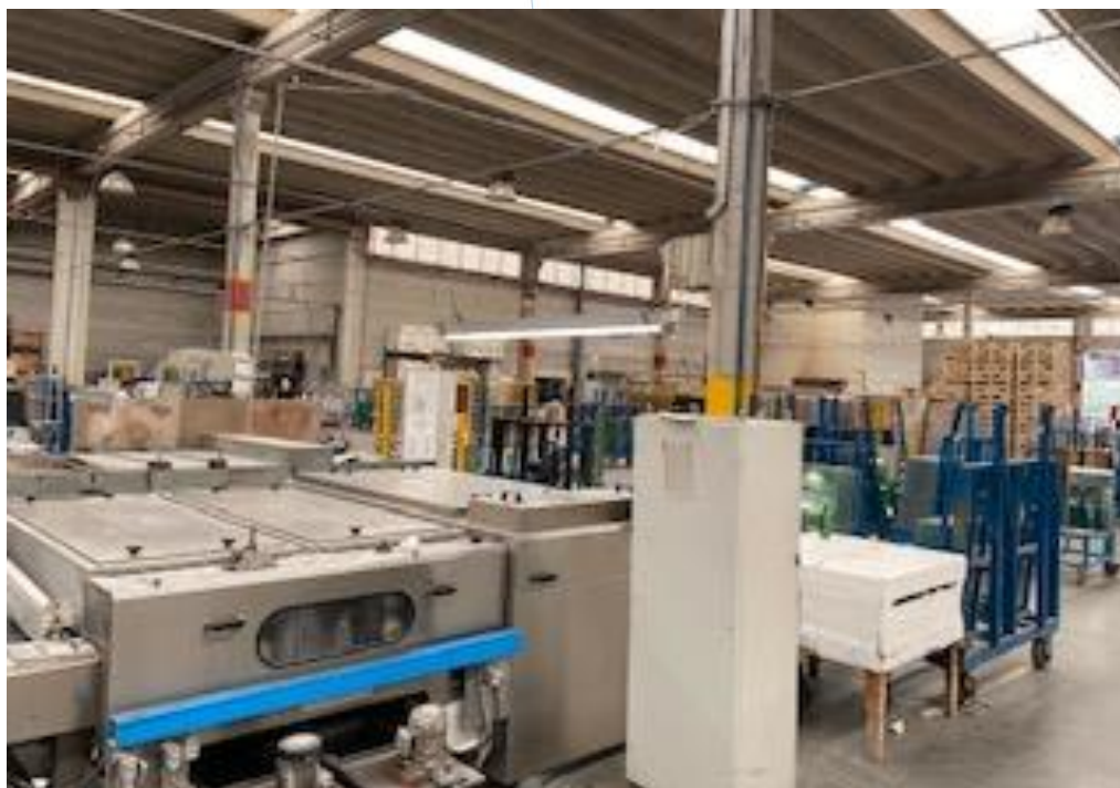
Foto 013: Maquinário operando normalmente
