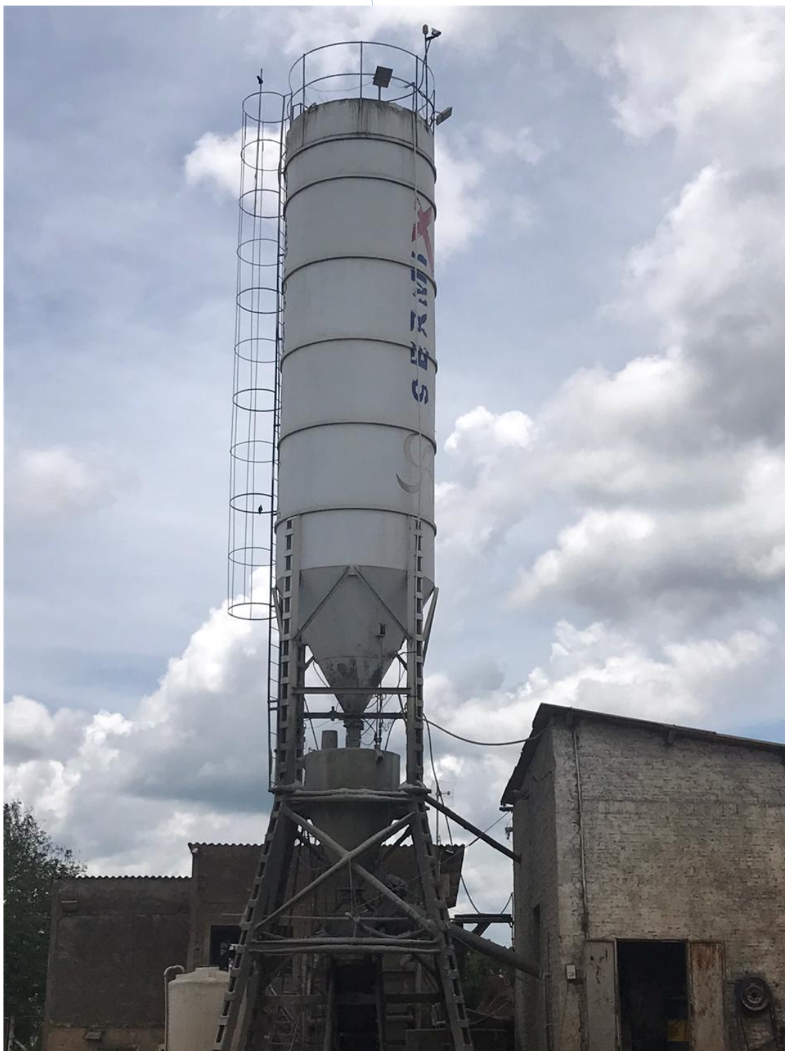
Foto 021: Torre de concreto
