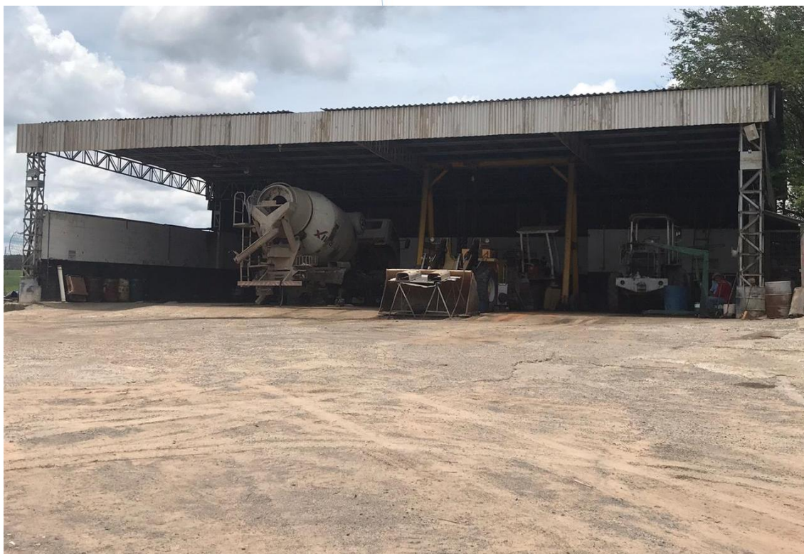
Foto 019: Área de manutenção
