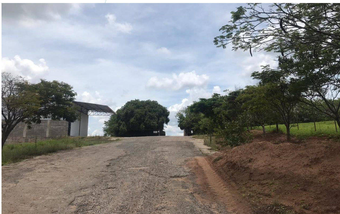
Foto 002: Estrada para às dependências da empresa
