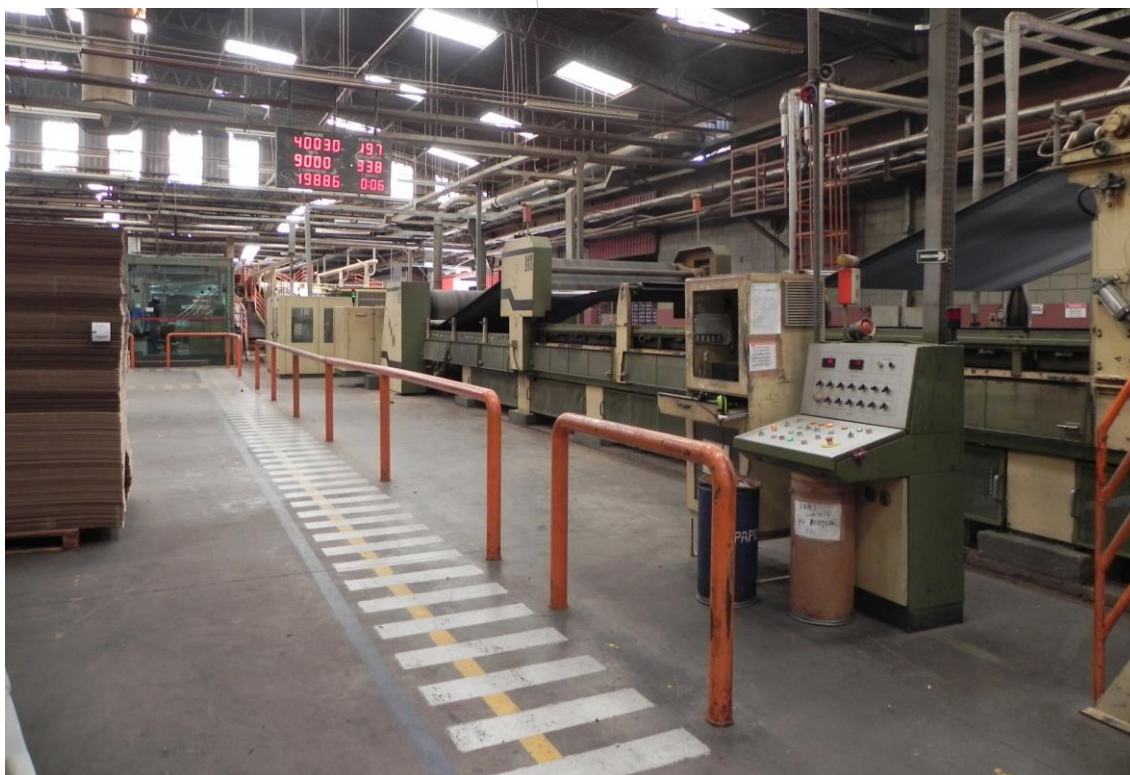
Foto 019: Maquinário operando normalmente
