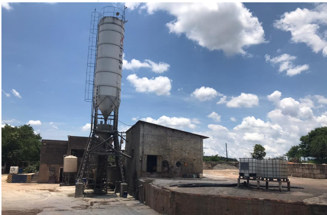
Foto 018: Torre de concreto
