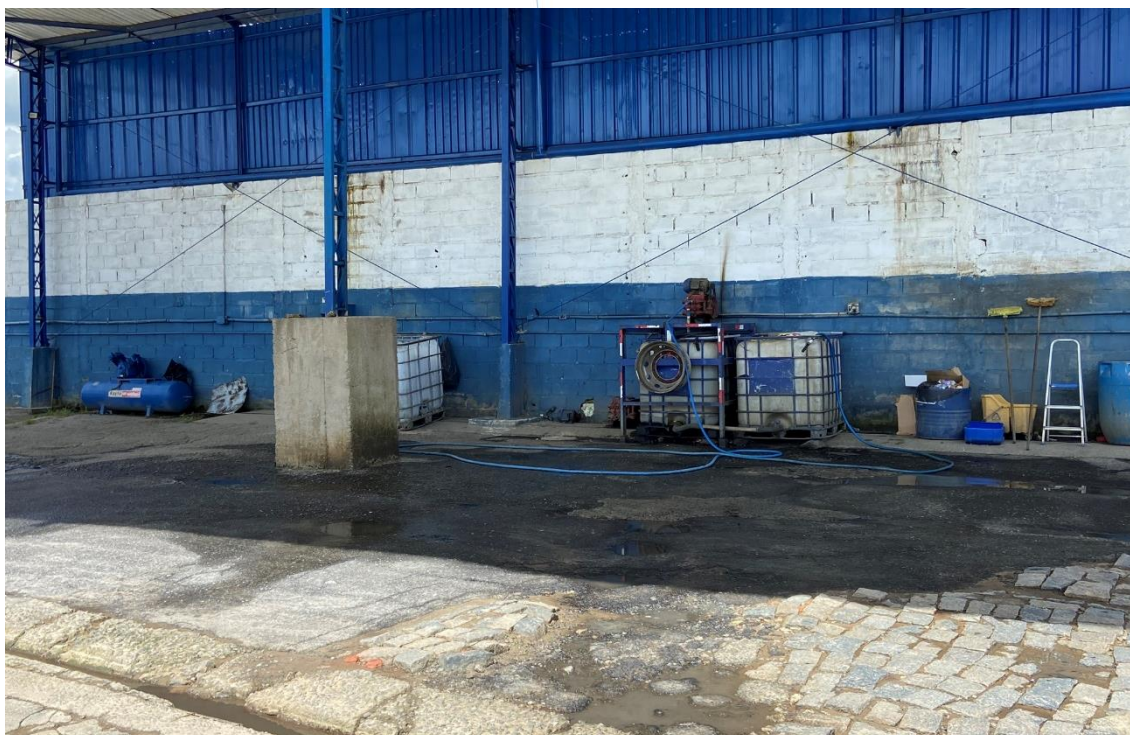
Foto 009: Setor de lavagem
