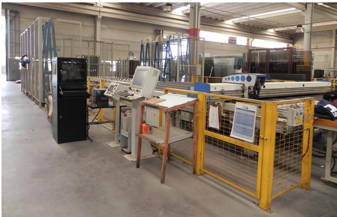
Foto 004: Vista do setor operacional
