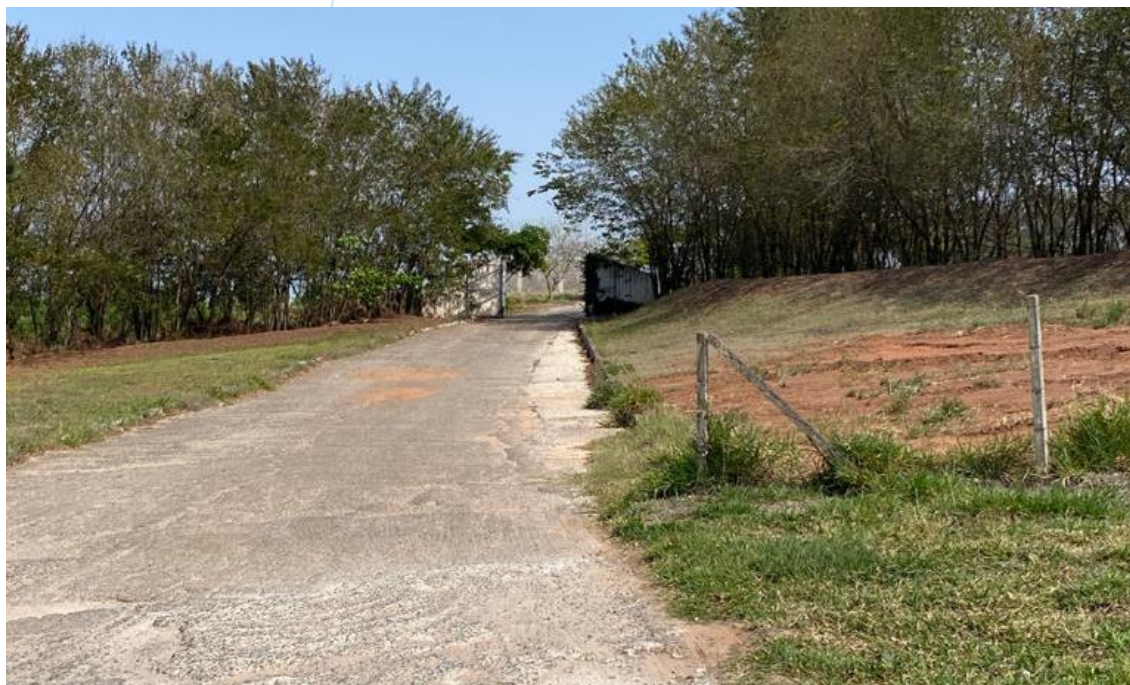
Foto 002: Entrada para as dependências da empresa
