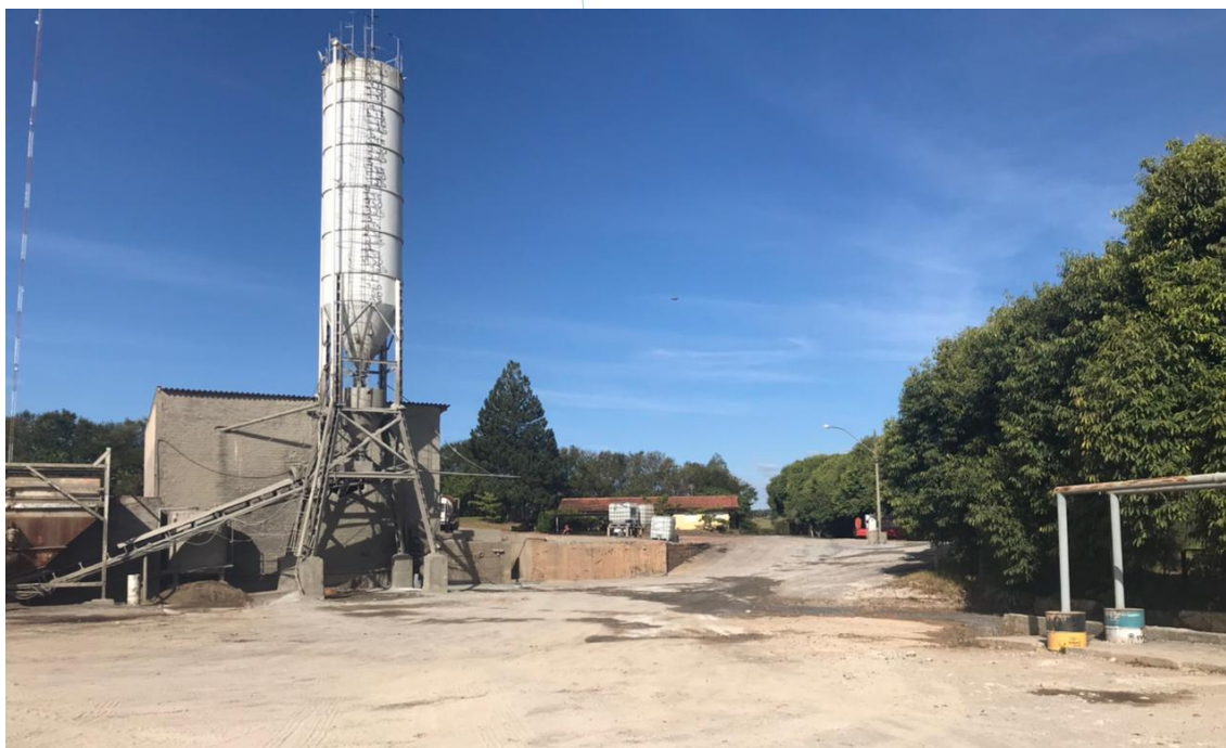
Foto 019: Torre de concreto
