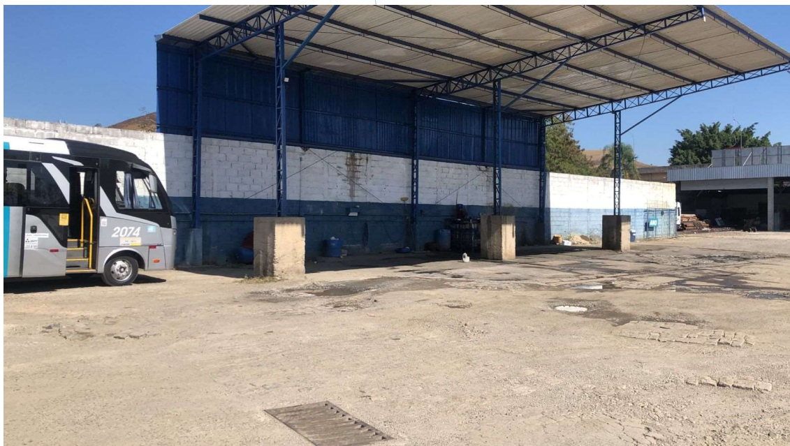
Foto 011: Área de lavagem de caminhões
