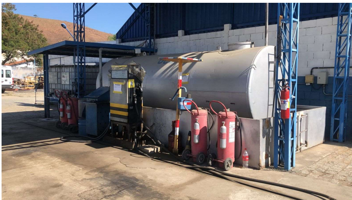
Foto 013: Área de abastecimento
