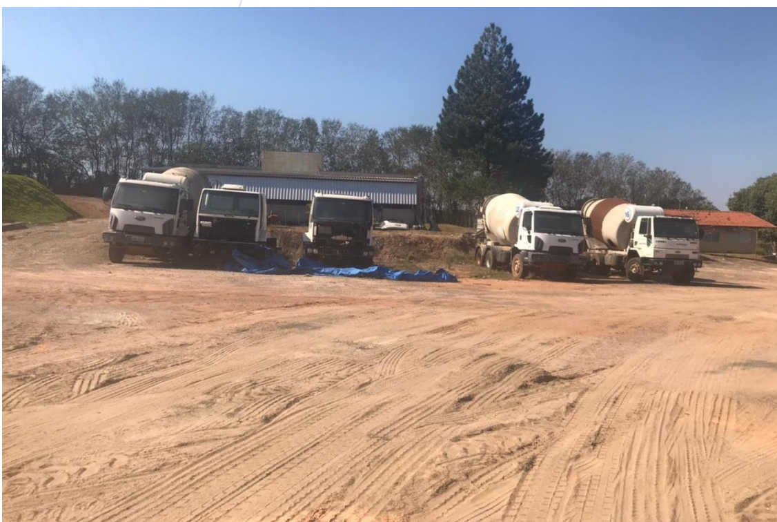
Foto 021: Caminhões aguardando manutenção
