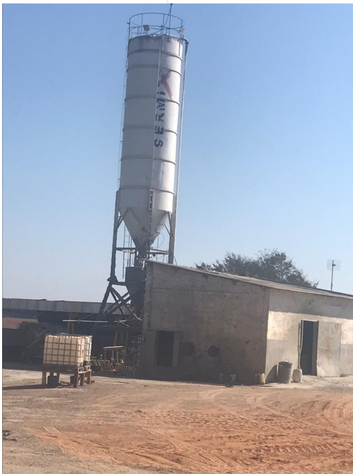
Foto 019: Torre de concreto
