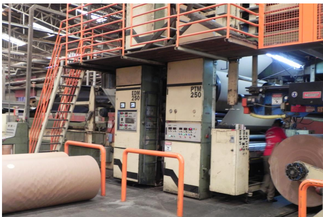
Foto 014: Onduladeira operando normalmente
