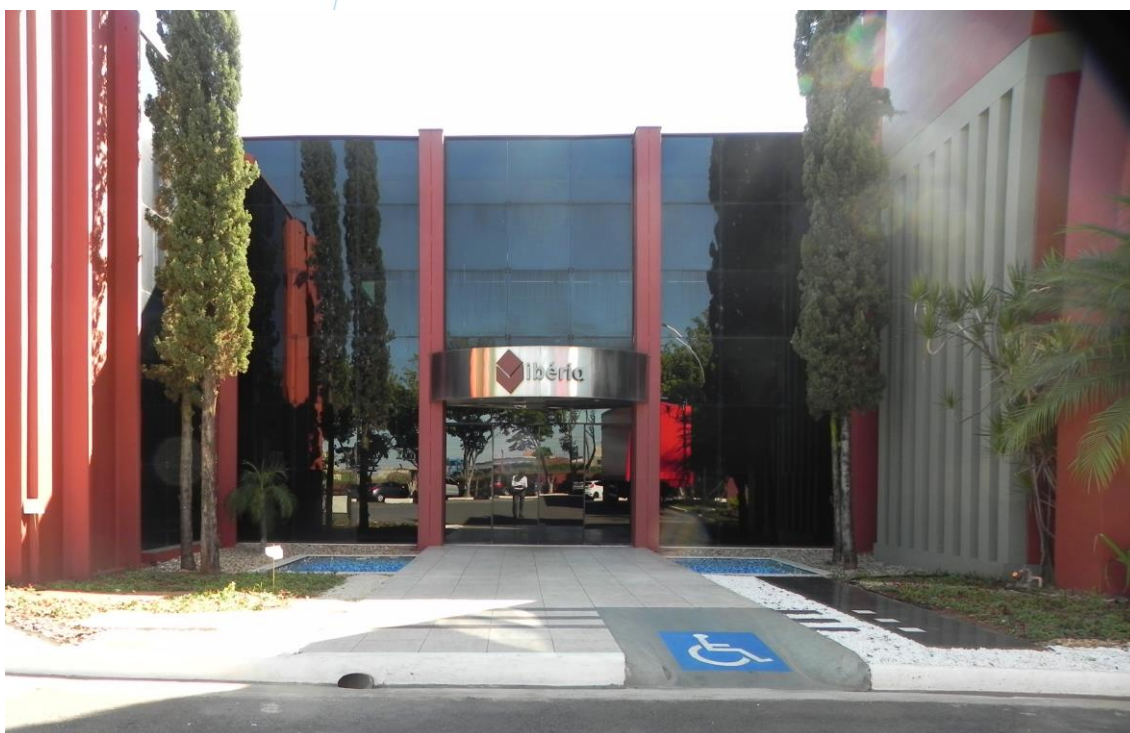
Foto 004: Entrada para recepção e setor administrativo
