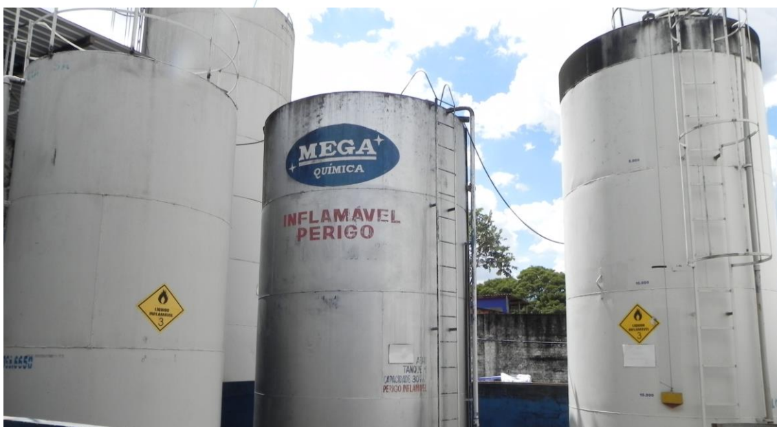
Foto 014: Depósito de inflamáveis
