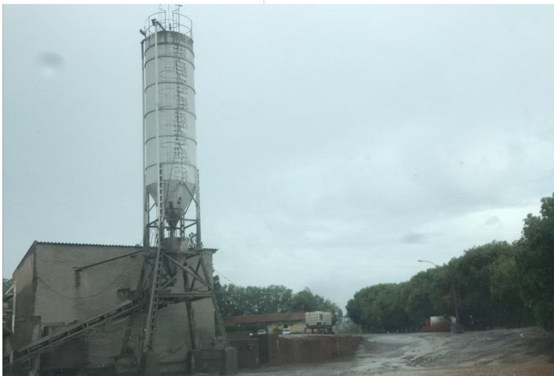
Foto 021: Torre de concreto
