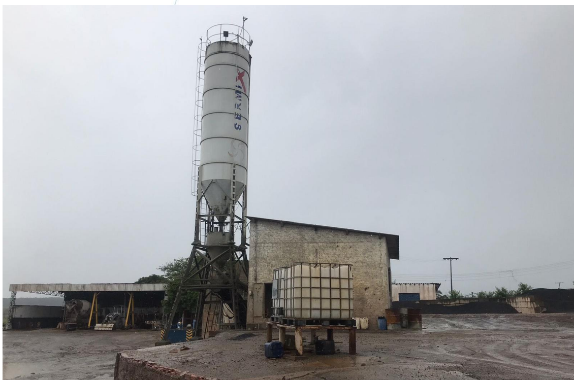
Foto 014: Vista ampla do setor de concretagem
