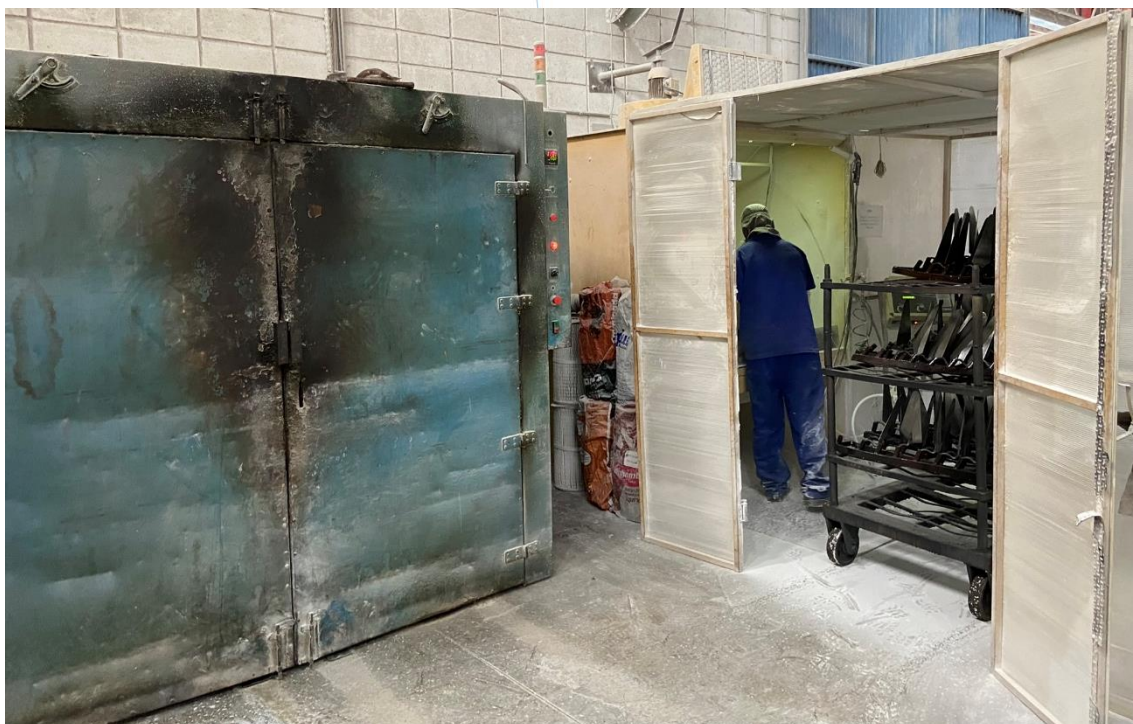
Foto 015: Câmara de pintura
