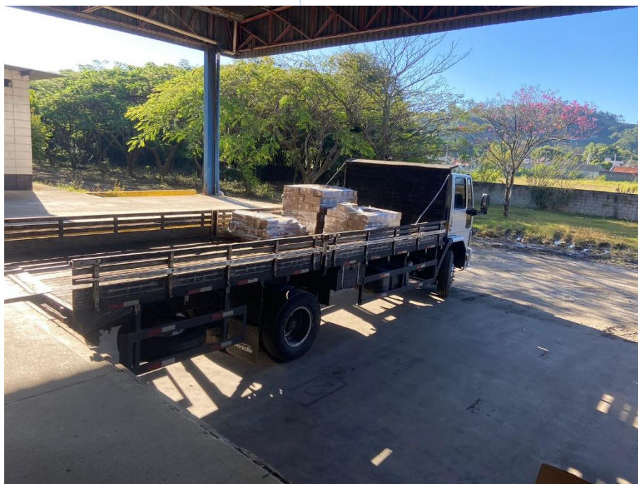
Foto 009: Descarga de materiais
