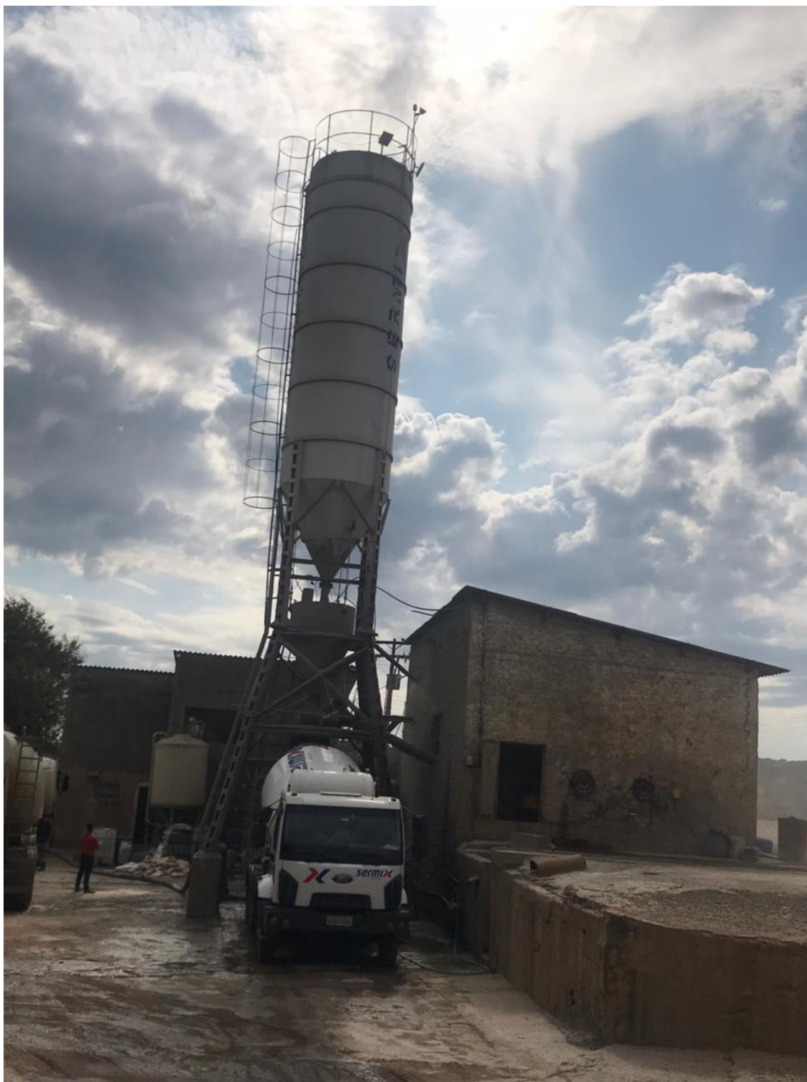
Foto 011: Vista ampla do setor de concretagem e da torre de concreto
