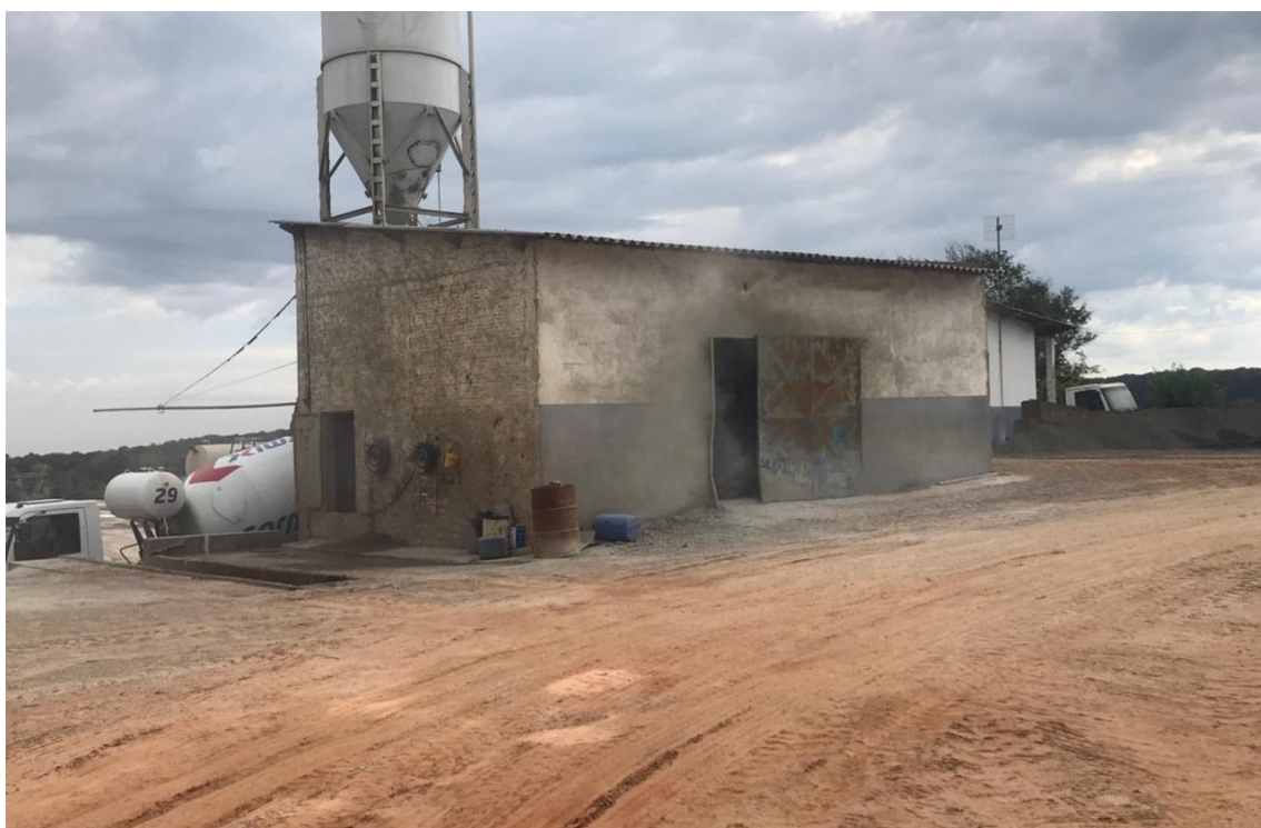
Foto 010: Estoque de cimento
