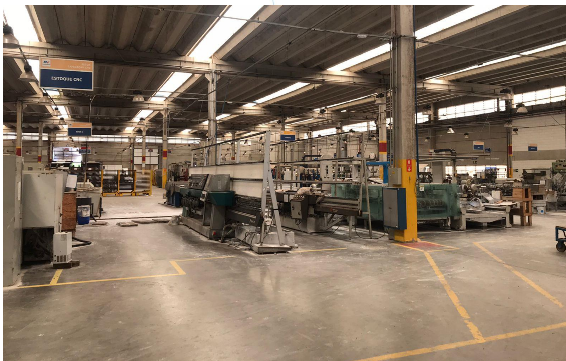
Foto 005: Setor operacional ( Continuação 01 )
