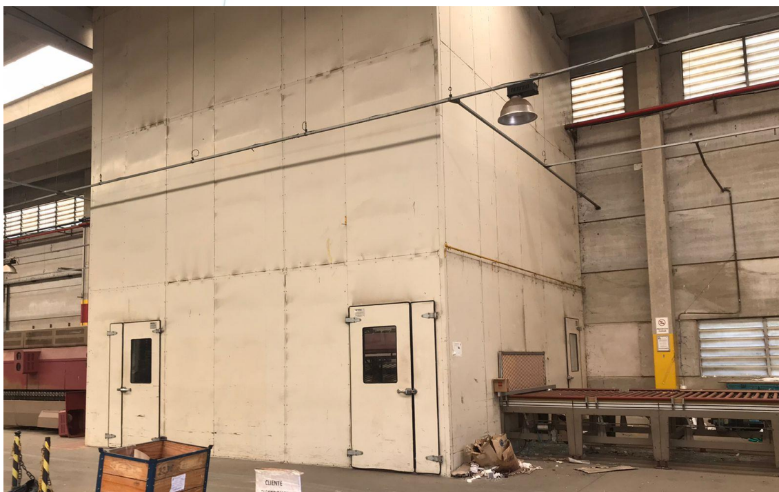
Foto 006: Setor operacional ( Continuação 02 )
