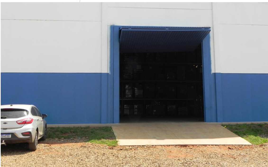
Foto 014: Entrada para às dependências internas do galpão
