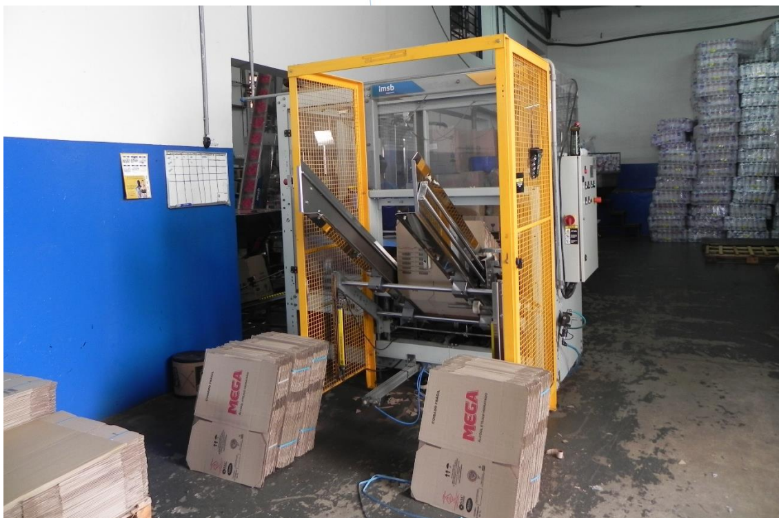
Foto 009: Maquinário operando normalmente
