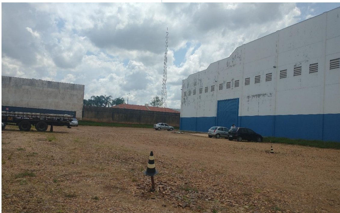
Foto 016: Vista das dependências internas do galpão
