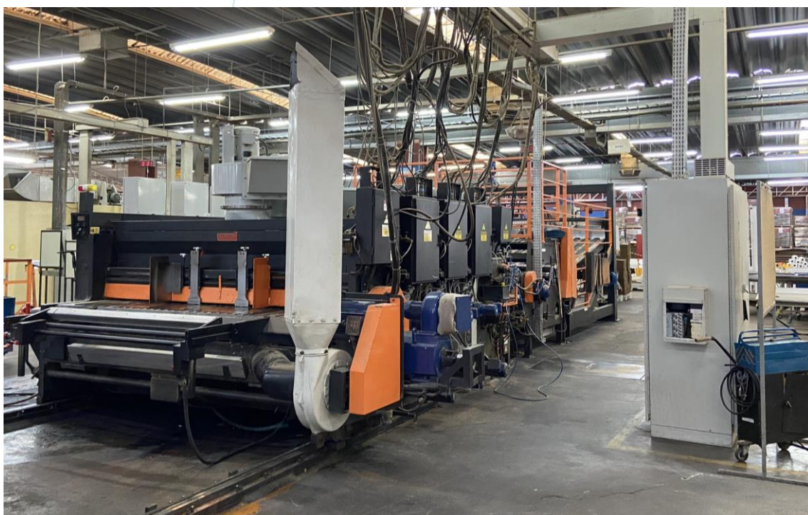
Foto 016: Maquinário operando normalmente ( continuação )
