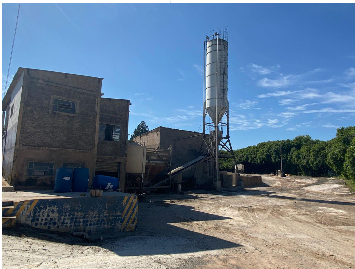
Foto 009: Ampla visão do setor de concreto e da torre de concreto
