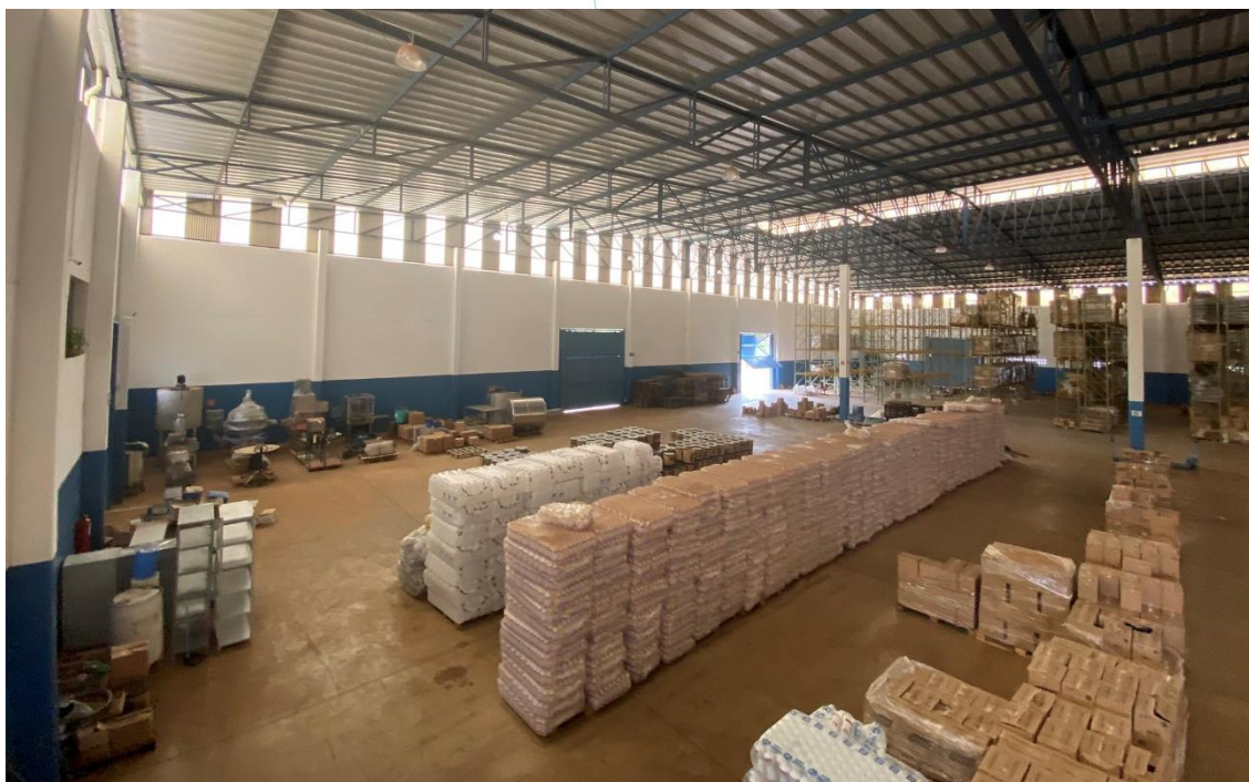
Foto 009: Vista superior do galpão de expedição ( continuação )
