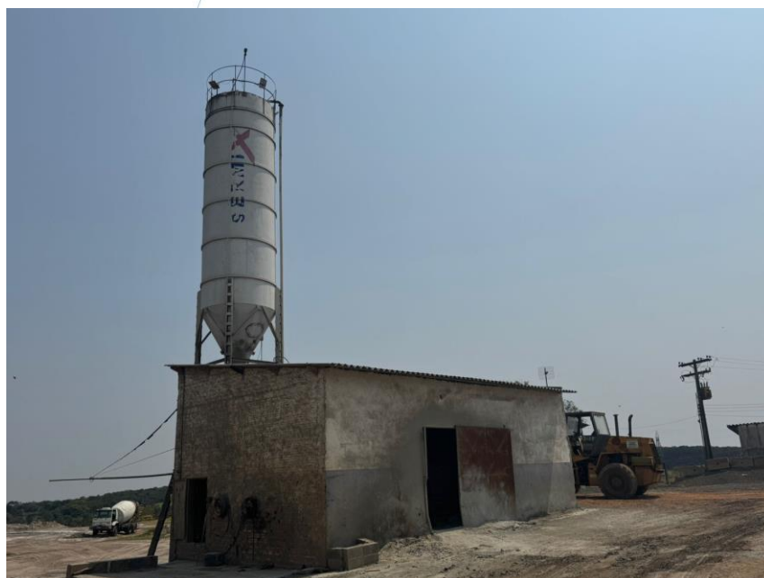
Foto 012: Tanque de Concreto
