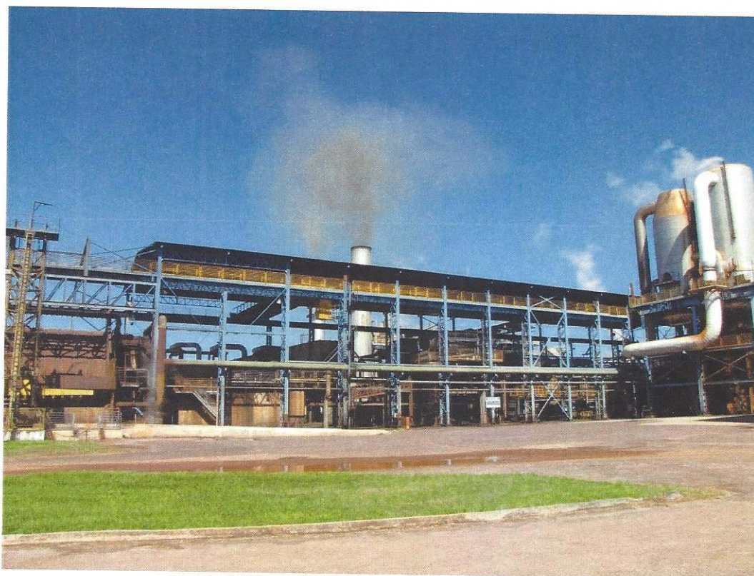
09-Vista geral linha de moagem
