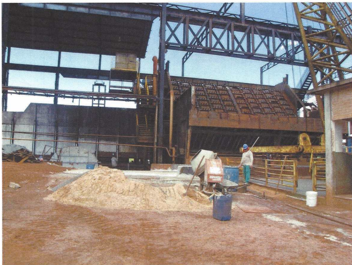
05-Área de descarga em manutenção
