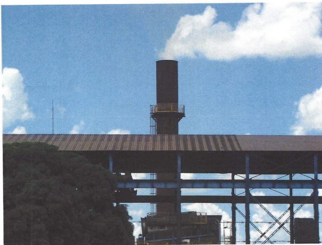
03-Caldeira em aquecimento
